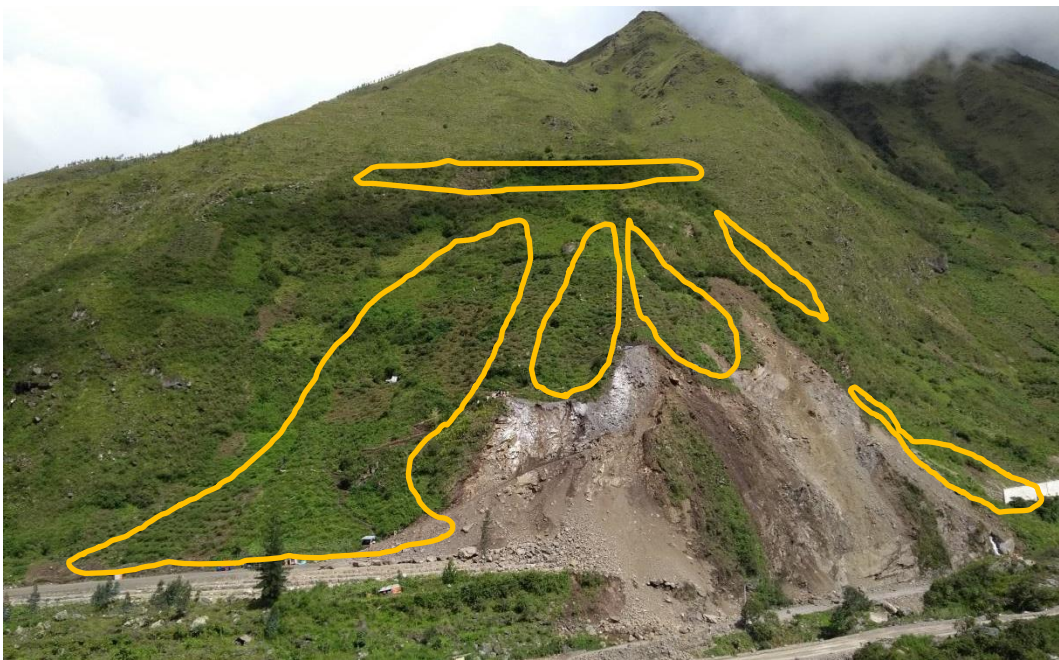
Figura 41 Depósitos coluviales presentes en las depresiones estructurales de la ladera con alto riesgo de derrumbamientos sobre la vía.
