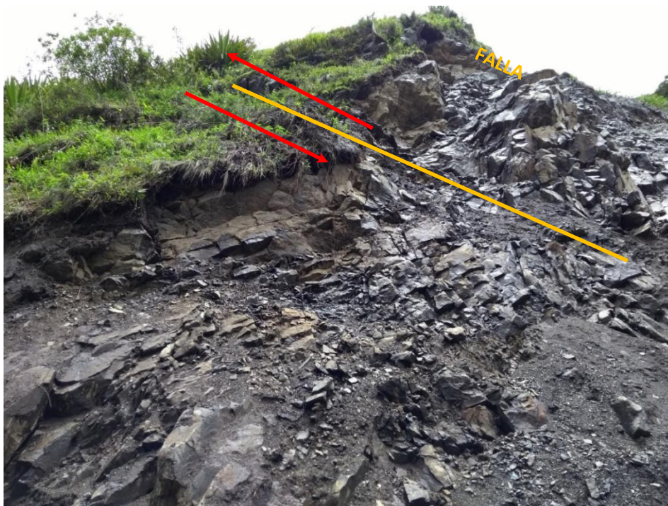
Figura 17 Aspecto del macizo rocoso en el PK 241+220.
