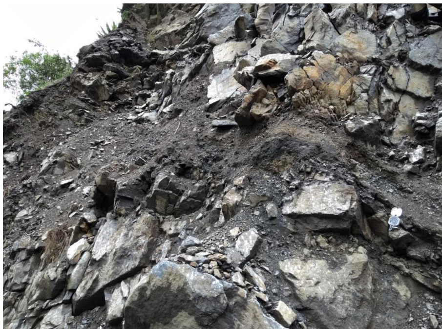
Figura 18 Detalle de la falla identificada en el PK 241+220.
