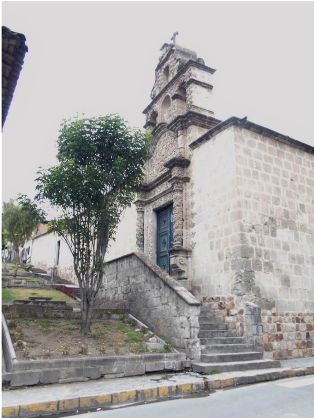
Fotografía 3: Ex Hospital de Mujeres del Complejo Monumental Belén 57
