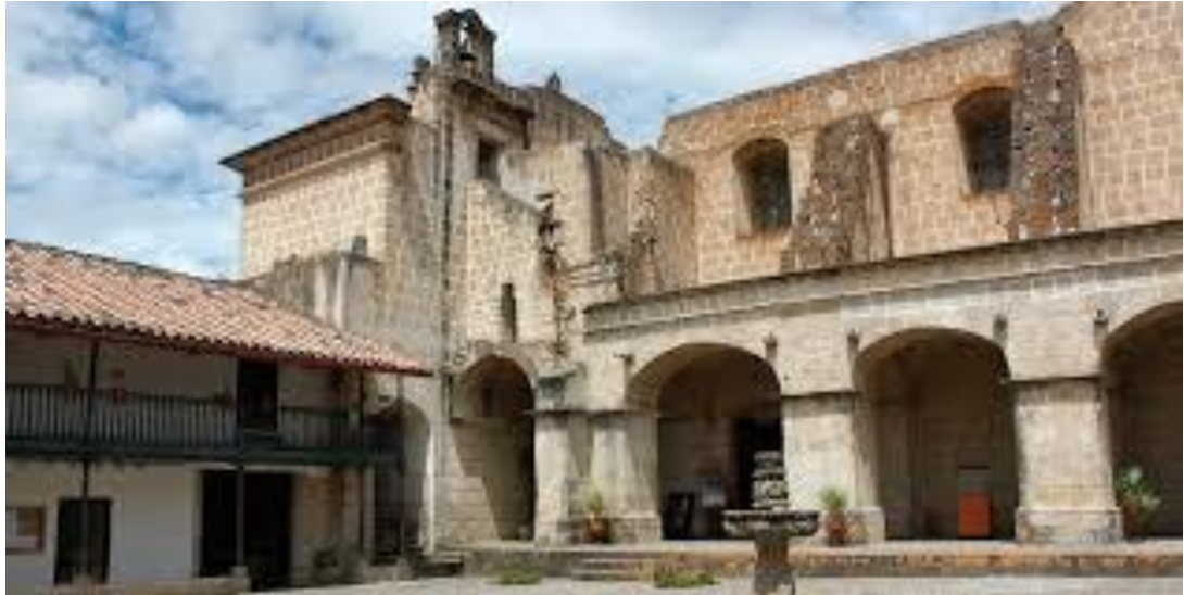
Imagen 15: Complejo Belén (Interior) – Cajamarca. 14
