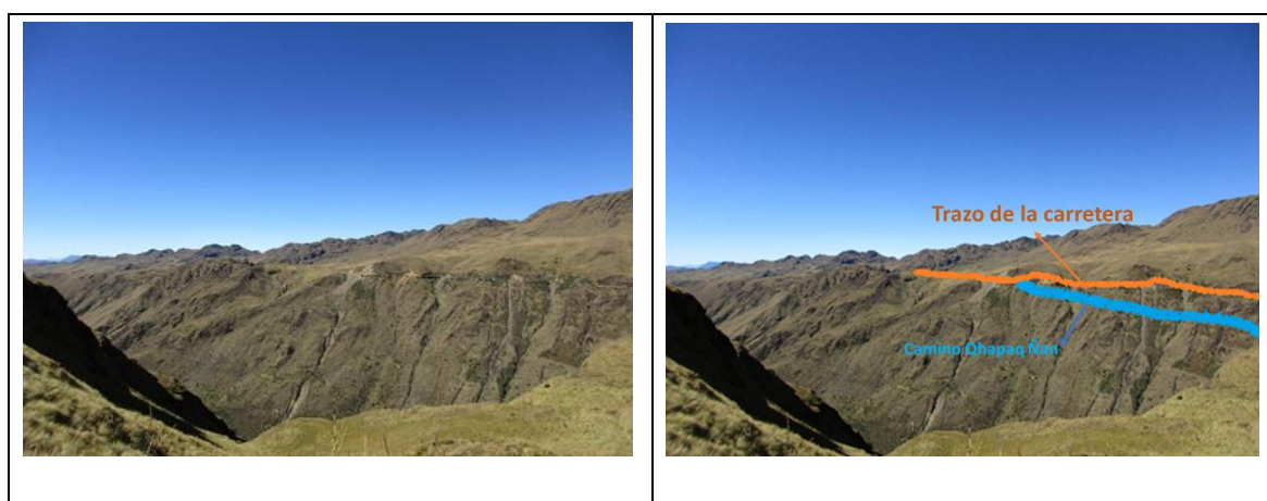
Figura 9. Soterramiento del camino del Qhapaq Ñan por construcción de carretera anexo Pumaqocha . Fuente: Autoría propia.
