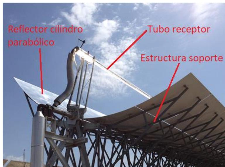
Figura 14 Componentes principales del campo solar [12]
