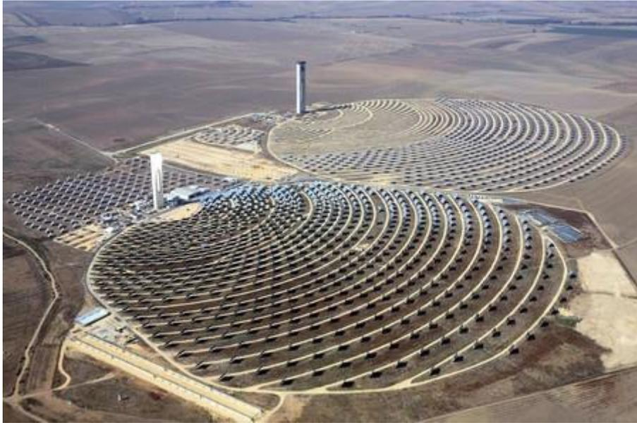
Figura 21 Plantas termosolares PS10 y PS20 con campo Norte. [19]
