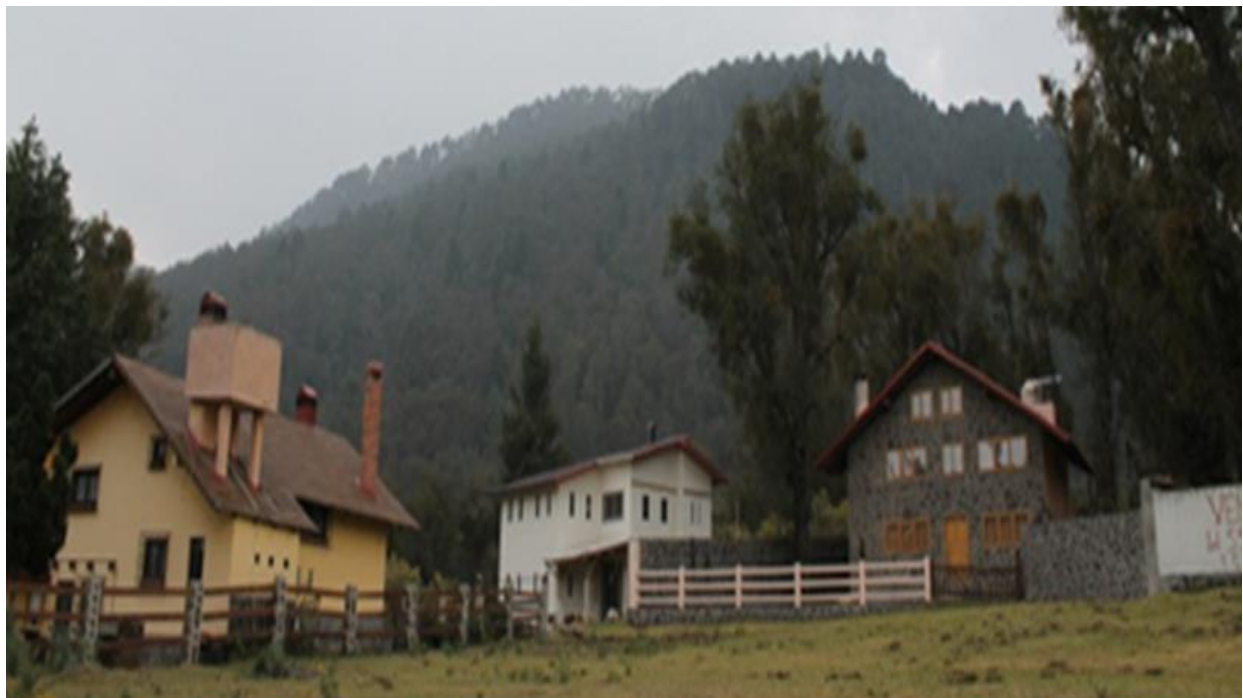
Ilustración 91: Presencia de Cabañas con Urbanismo Defensivo o Cerrado presente en la zona interior del FBVT, Fuente: 27 de marzo de 2016, Foto: Gonzalo A. Torres Z.
