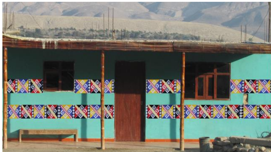
Fachada luego de la intervención
