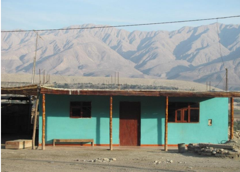
Fachada sin intervenir
