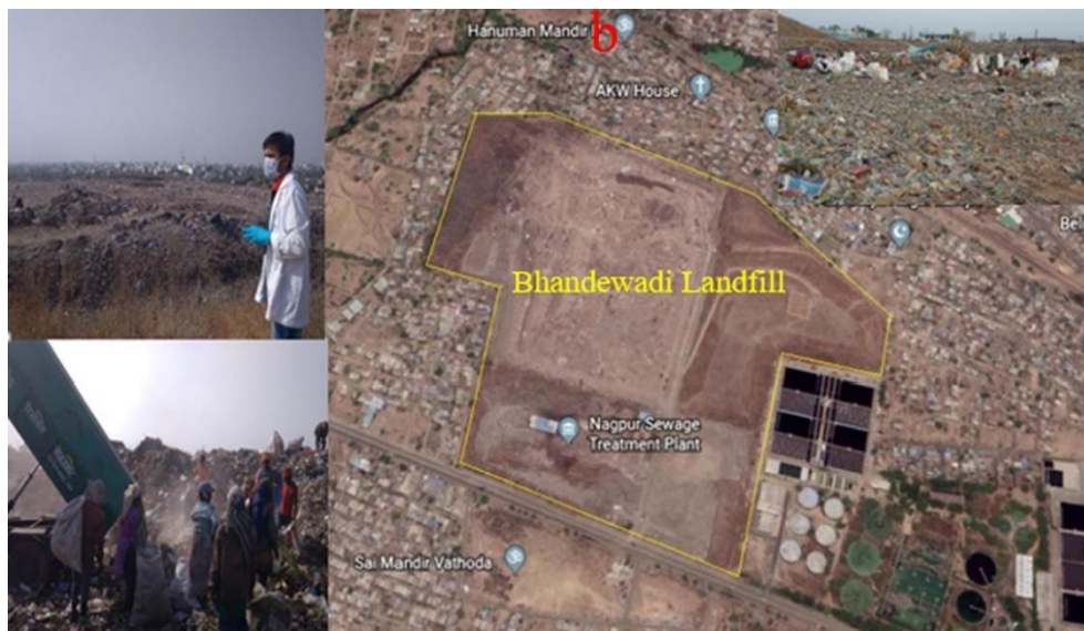
Figura 3 - Aterro sanitário de Bhandewadi, Bangalore, Índia. 1.200 tons de resíduos por dia. Fonte: Adaptado de Manjunatha et al. 25 .
