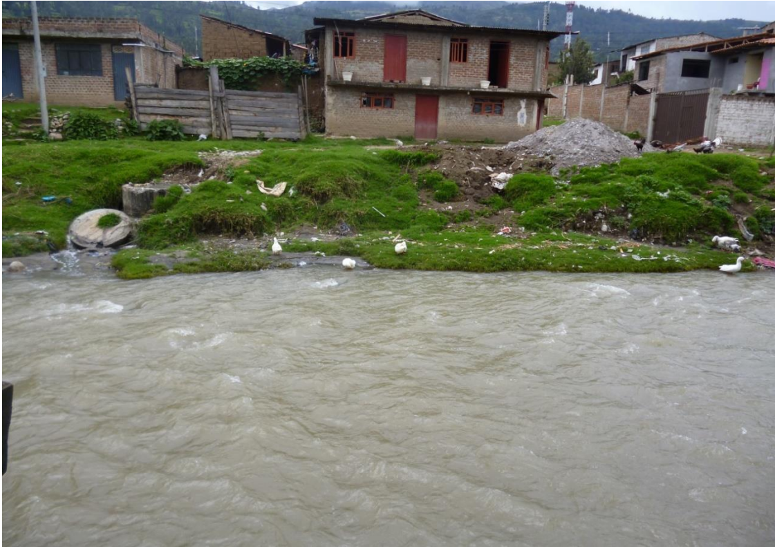
Figura 3. Red de Alcantarillado Vecinal que Desemboca las Aguas Residuales al Río Chumbao - Andahuaylas.
