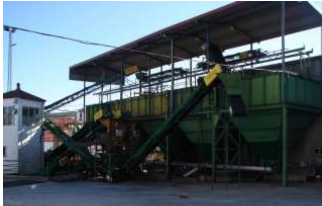
Figura 2.7 Almazara San Sebastián Guadalcanal, Sevilla Fuente: https://www.ingerhidro.com/proyectos/san-sebastian-guadalcanal-sevilla
