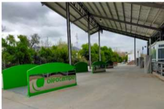
Figura 2.8 Zona de recepción y tolvas enterradas. Centro de Producción S. Bartolomé, perteneciente a SCA Oleocampo de Torredelcampo, Jaén. (Fuente: Elaboración propia )
