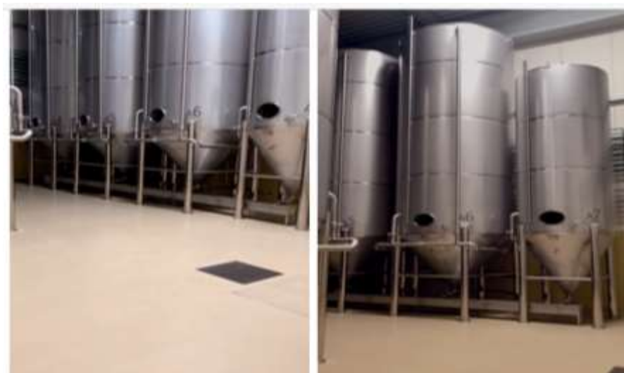
Figura 2.28 Decantadores Aclaradores con 15 y 50° de inclinación Fuente: (Amezcuca et al., 2019).
