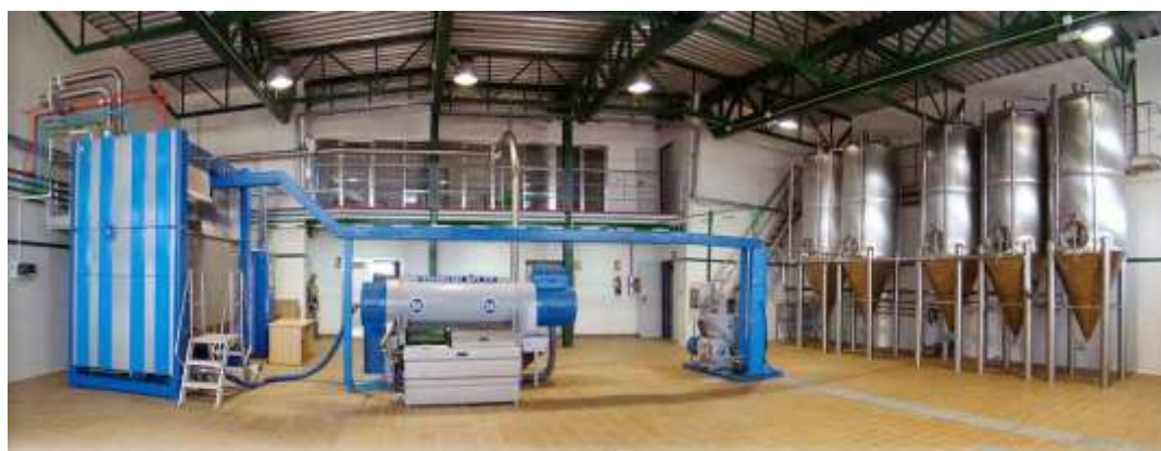
Figura 2.18 Instalaciones de Agropecuaria Ecológica Sierra de Alcaraz (Fuente: https://www.interempresas.net )
