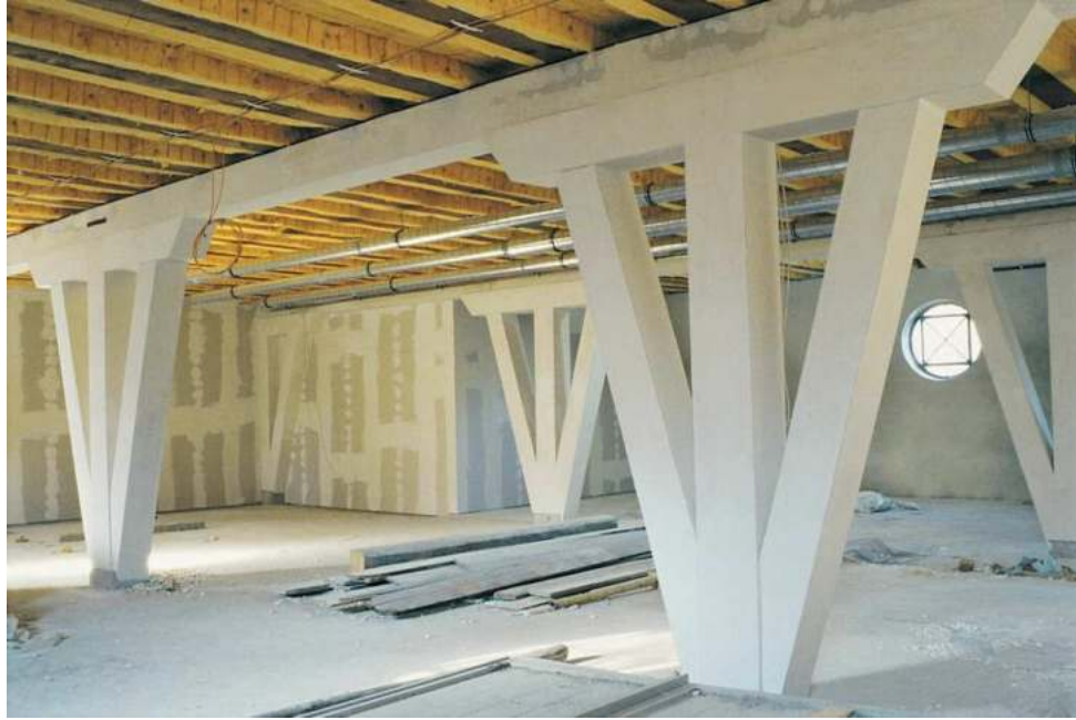
Рисунок 1.18 – Обшивка несущих деревянных элементов гипсокартоном
