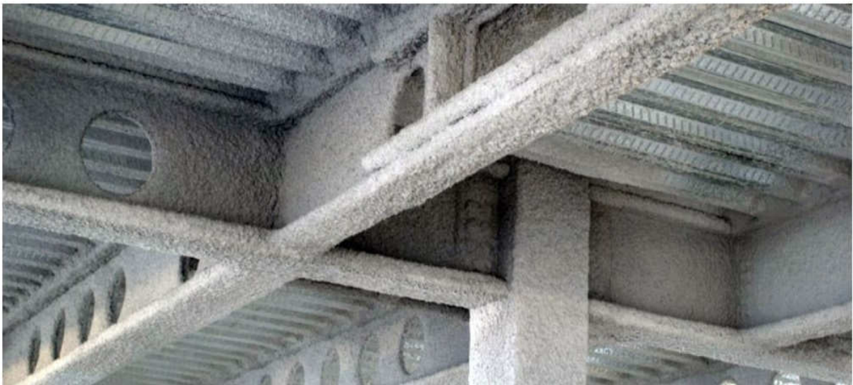
Рисунок 1.19 – Обработка стальных несущих элементов противопожарным составом
