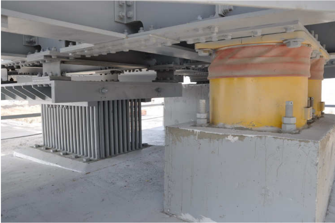
Рисунок 1.14 – Варианты исполнения демпфирующих опорных участков для обеспечения сейсмостойкости
