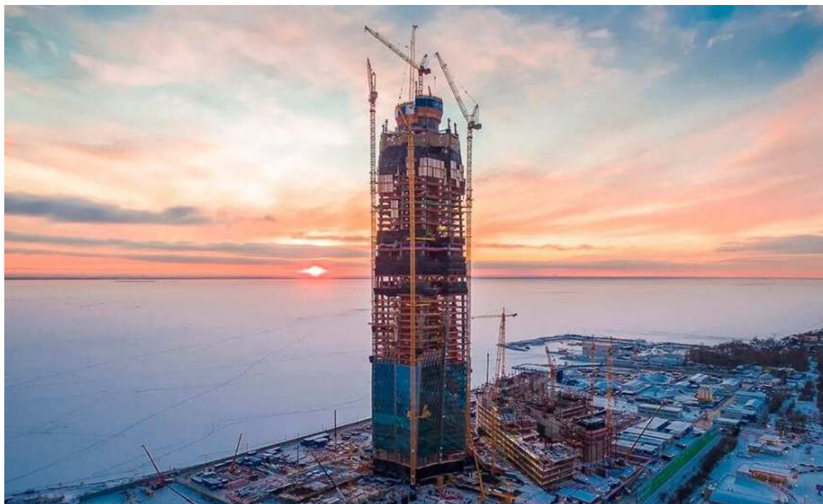
Рисунок 1.15 – Возведение Лахта центра в г. Санкт-Петербурге с применением центрального ядра жесткости.
