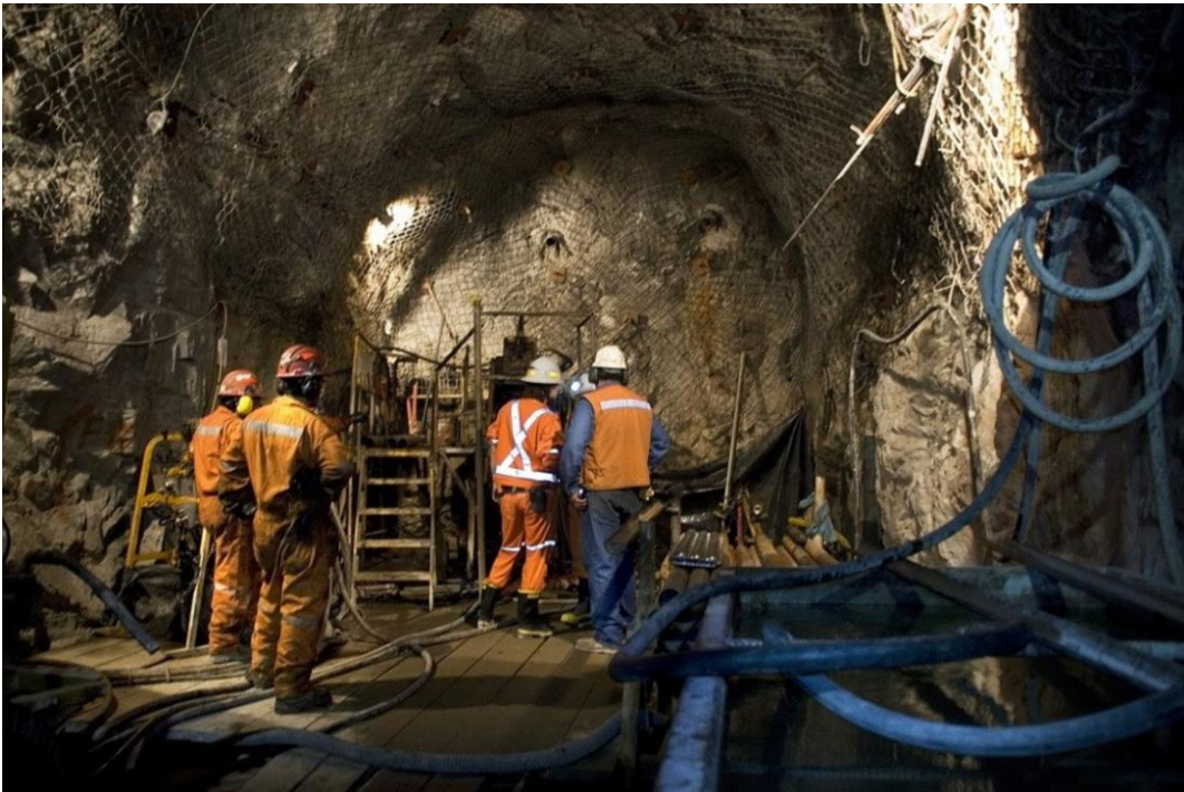
Figura 0.6. Preparación de voladura.
