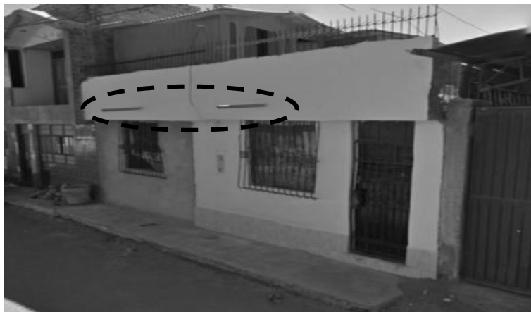
Photo 7. Drainage pluvial du toit de résidence typique (GE, 2015)
