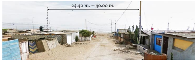
Imagen 142 Vía secundaria con dimensiones. Fuente: Elaboración propia en base a imagen de Google Street View
