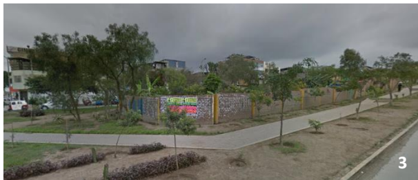
Imagen 82 Planta de tratamiento de aguas servidas para Villa el Salvador - Alameda de la juventud, Lima.
