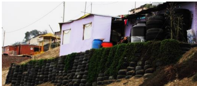
Imagen 146 Construcción de muros de contención con llantas.
