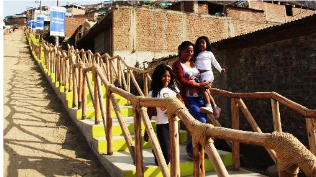
Imagen 145 Construcción de escaleras en asentamientos humanos.
