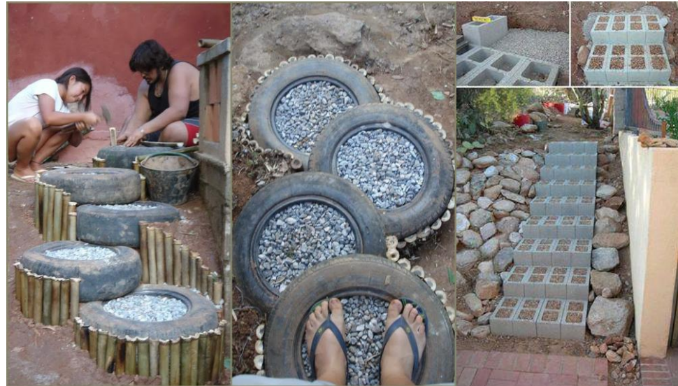
Imagen 171 Escaleras con neumáticos y piedra o bloques de hormigón con tierra. Fuente: (DETALLE FEMENINO, 2013) y (TARINGA, 2015)
