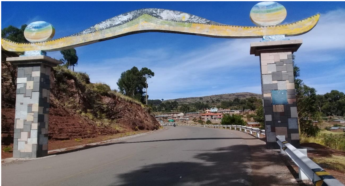
Figura 40. Mejoramiento de la infraestructura vial de la comunidad de Llachón ,05 de enero de 2021, Llachón Puno – Perú
