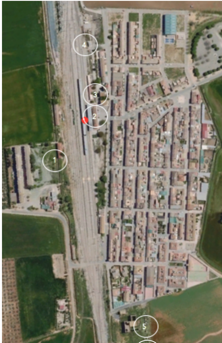
Imagen 11: Vista de Bobadilla Estación. Fuente: Google Maps.
