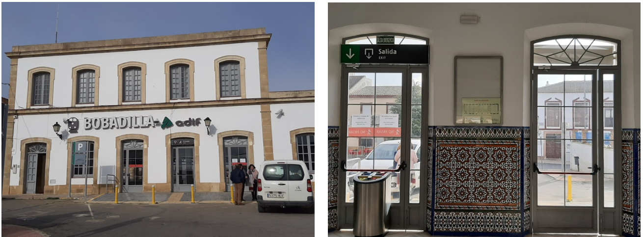
Imagen 13. Detalles del interior y exterior de la Estación de Bobadilla. Fuente: elaboración propia
