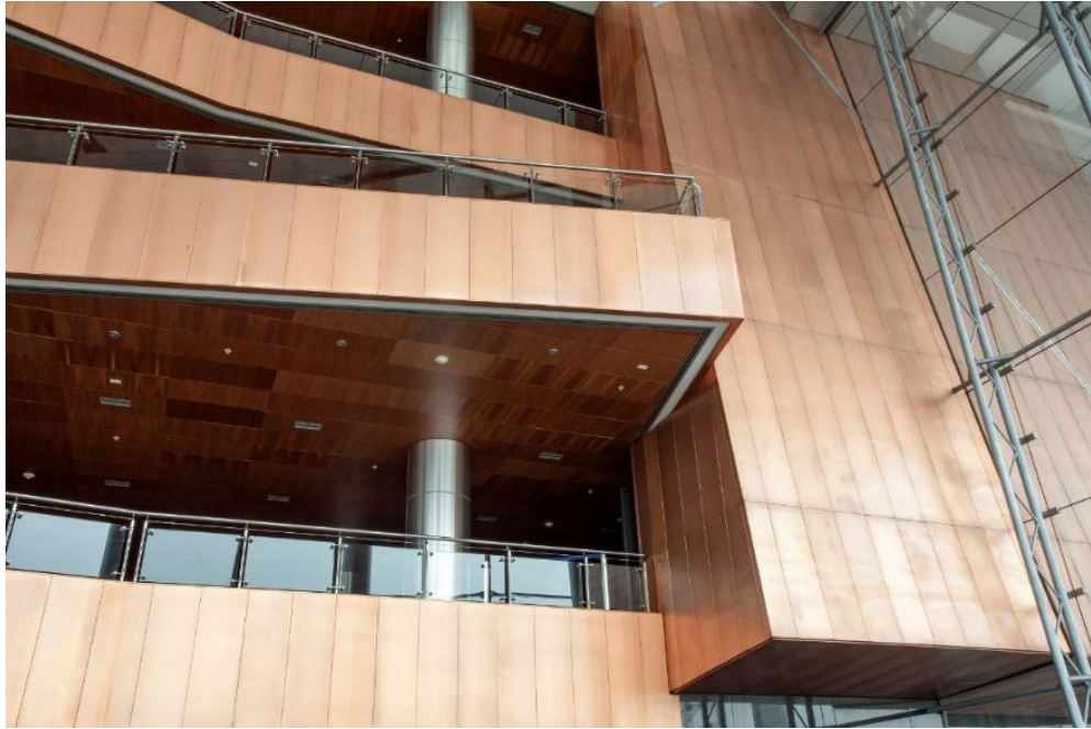
IMAGEN 44. Zona del Foyer y lobby del Gran teatro de Lima con sus paredes enchapadas en cobre
