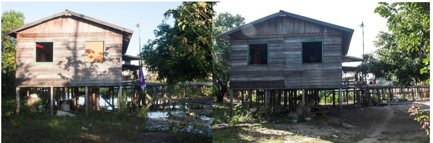
Figuras 13&14: Exemplos de estrutura de madeira característica da várzea construída acima do nível do piso por ser uma área anualmente inundada. Nas fotos se apresenta uma mesma casa localizada na comunidade quilombola de Surubiu-Açú, tendo sido registrada em duas épocas do ano diferentes. A primeira foi no mês de junho de 2018, no final do chamado “inverno amazônico”; a segunda foto foi no mês de outubro de 2018, em pleno “verão”. Fonte: Acervo pessoal.
