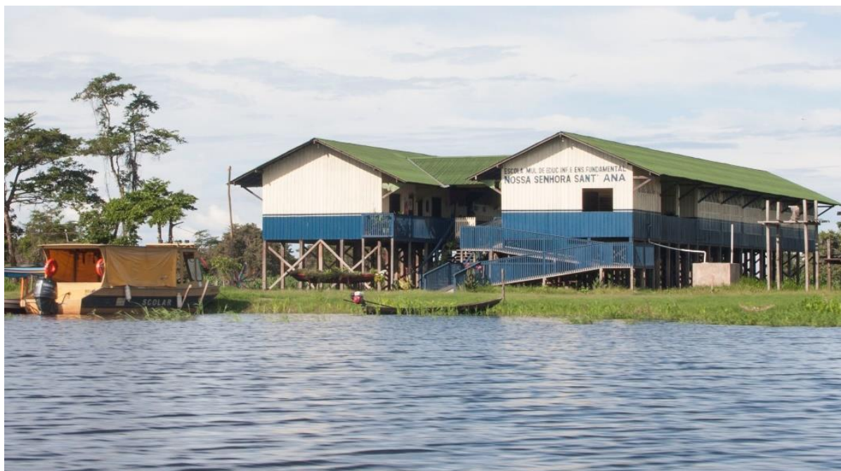
Figuras 57: Escola Municipal “Nossa Sra. Sant’Ana” localizada na comunidade quilombola de Arapemã. Observe-se a construção palafitada. Fonte: Acervo pessoal.
