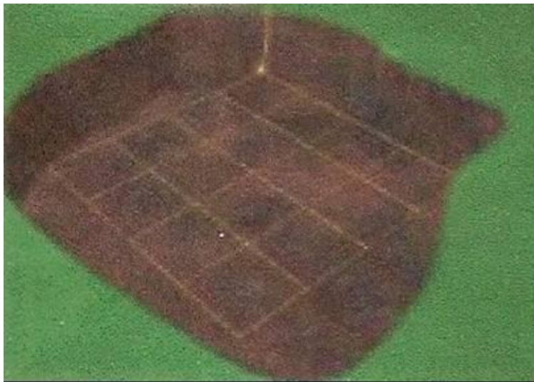
Figura 2.16. Malla de Tierra en forma de retículas. ( www.LEM.com )
