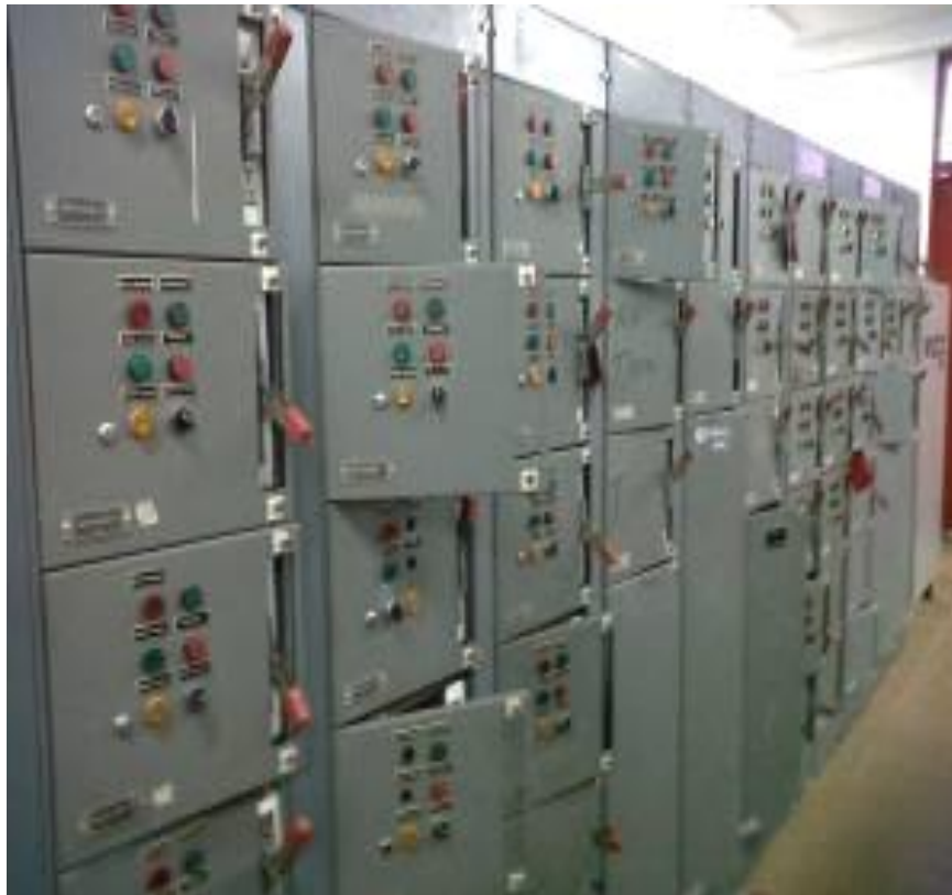
Figura 3.6 CCM servicios auxiliares Mesa
