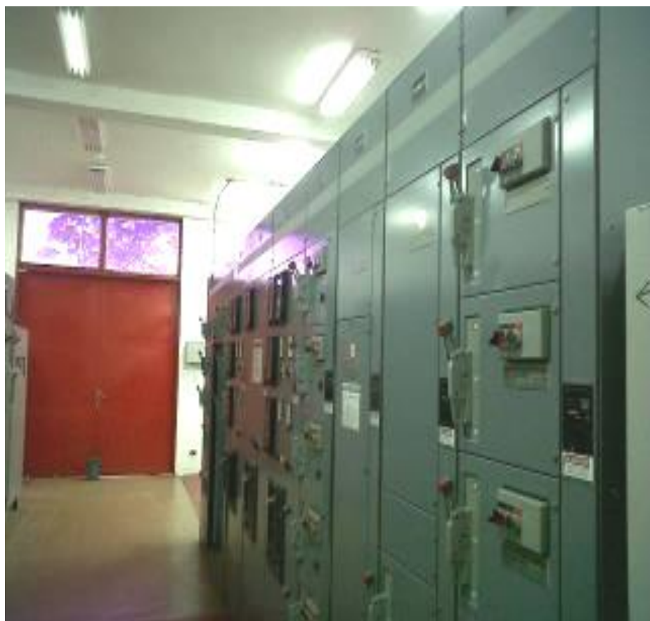
Figura 3.4 CCM servicios auxiliares Merrey
