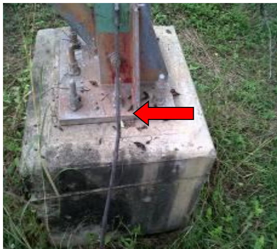
Figura 4.12 Torre de Comunicación.
