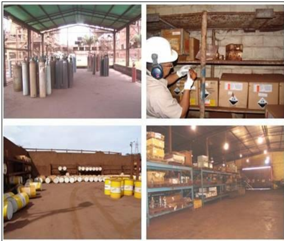
Figura 12. Superior izquierda: Jaula techada para cilindros de gases comprimidos (Almacén 2); Superior derecha: Reactivos y sustancias químicas; Inferior izquierda: Patio para almacén de combustibles y lubricantes nuevos; Inferior derecha: Almacén 1.
