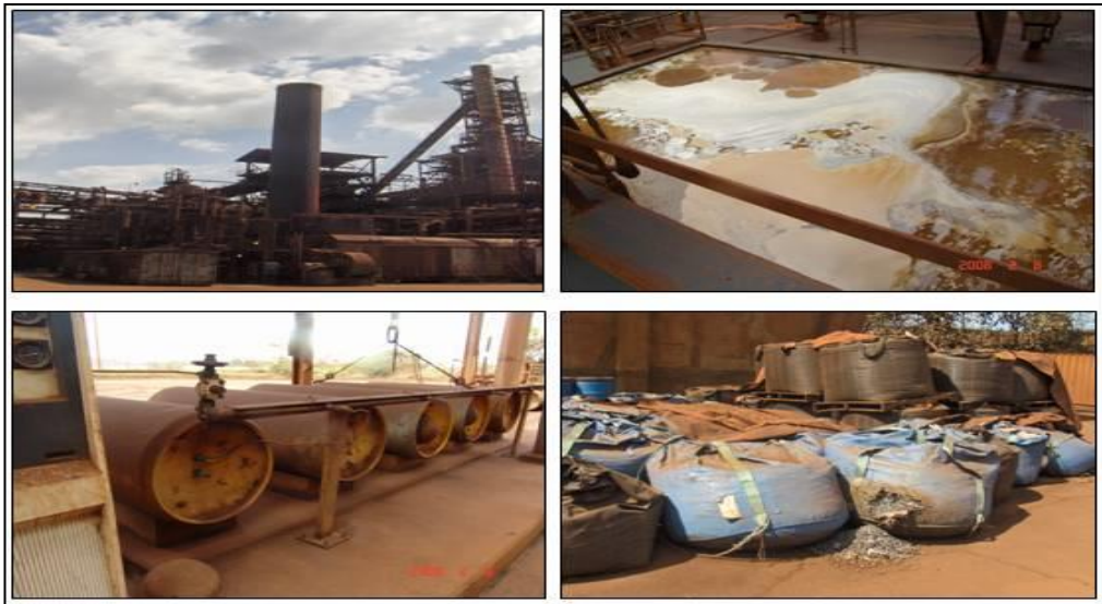
Figura 14. Superior izquierda: Gases contaminantes emitidos por las calderas de vapor; Superior derecha: Piscina de neutralización; Inferior izquierda: Cilindros de gas cloro; Inferior derecha: Almacenamiento temporal de catalizadores de níquel y reactivos químicos usados.
