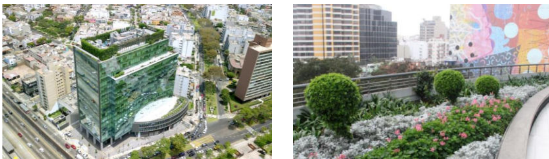
Fig. 81. Techo verde en edificio Leuro, Miraflores. Fuente: Techos Verdes ZinCo
