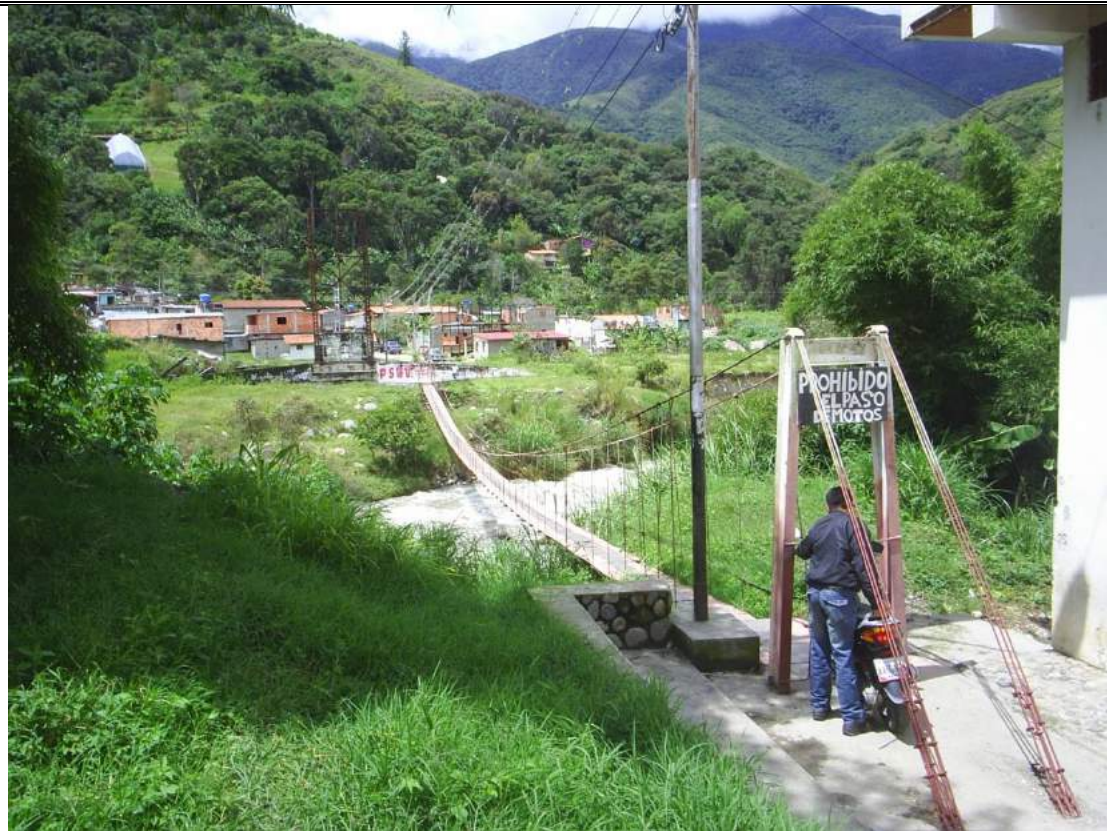
Foto 15: Descripción Fotográfica del puente colgante
