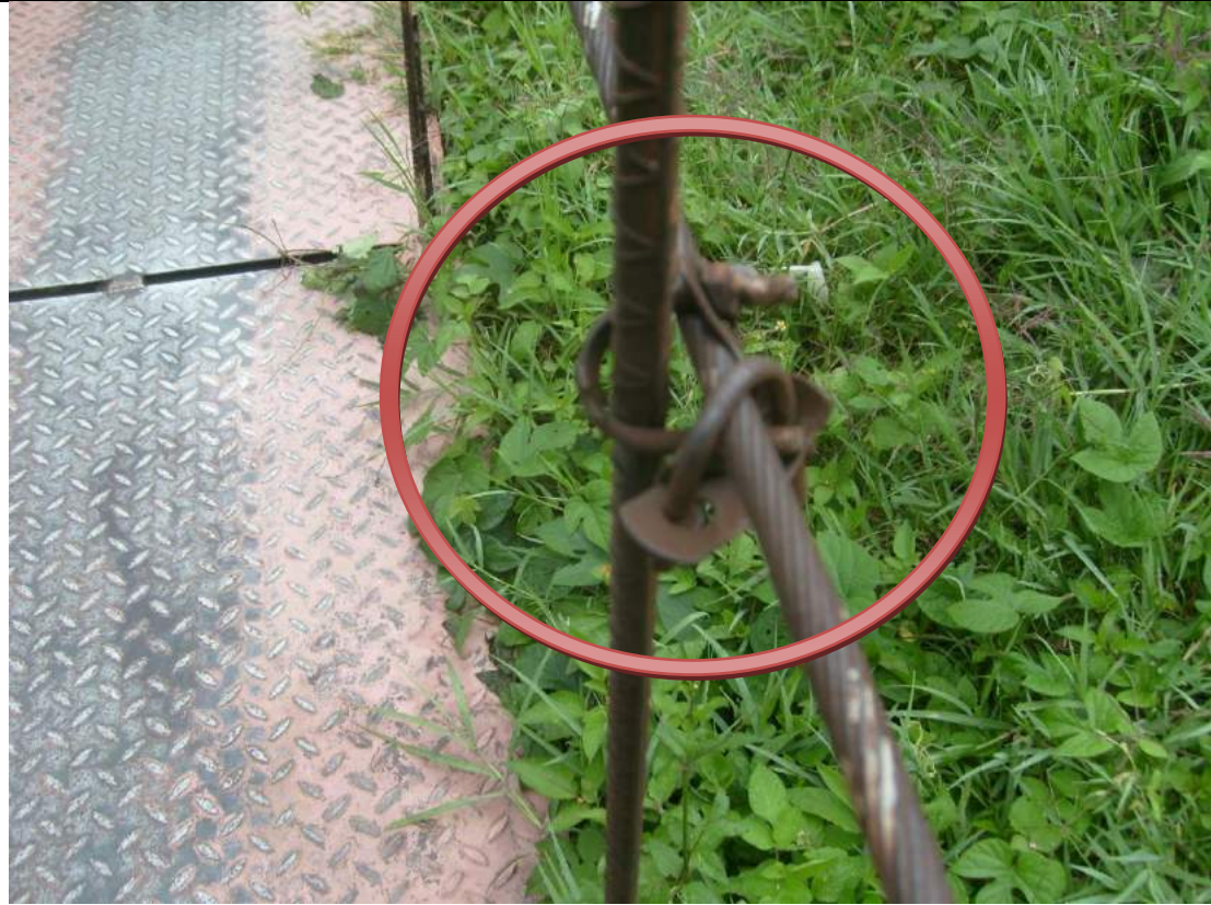
Foto 13: Descripción Fotográfica del puente colgante
