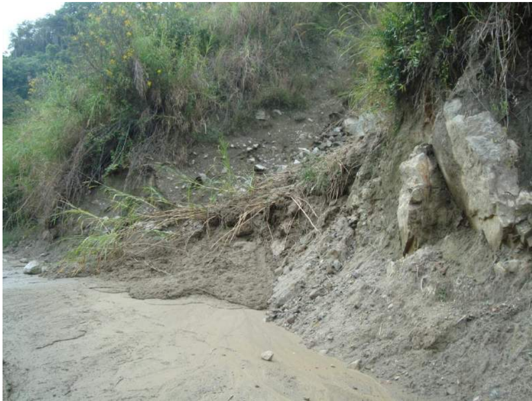
Foto 3: Descripción Fotográfica de la Vía Trasandina Troncal 007 (T-007)
