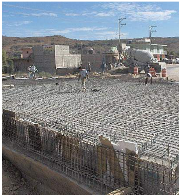
Figura. 7. Ejemplo de armado para losa de puente.
