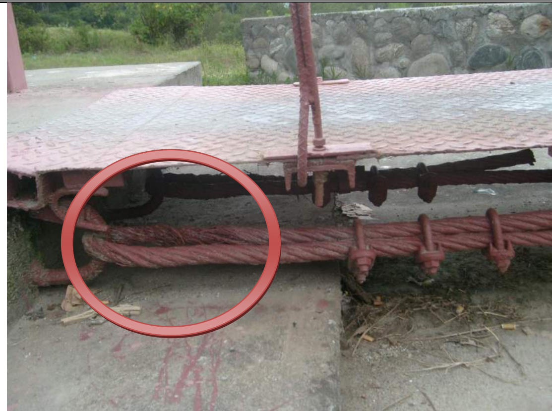
Foto 12: Descripción Fotográfica del puente colgante
