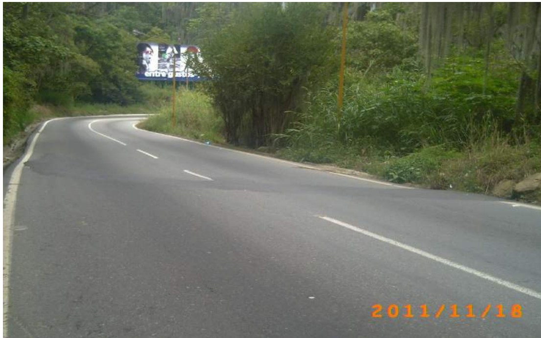
Foto 6: Descripción Fotográfica de la Vía Trasandina Troncal 007 (T-007)
