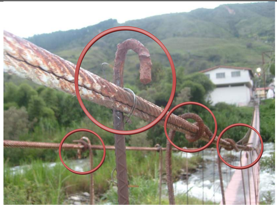
Foto 11: Descripción Fotográfica del puente colgante
