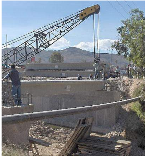
Figura. 8 Colocación de vigas de un puente.
