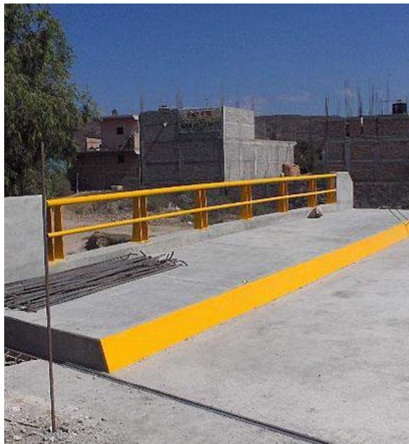
Figura 10. Barandas y aceras peatonales.
