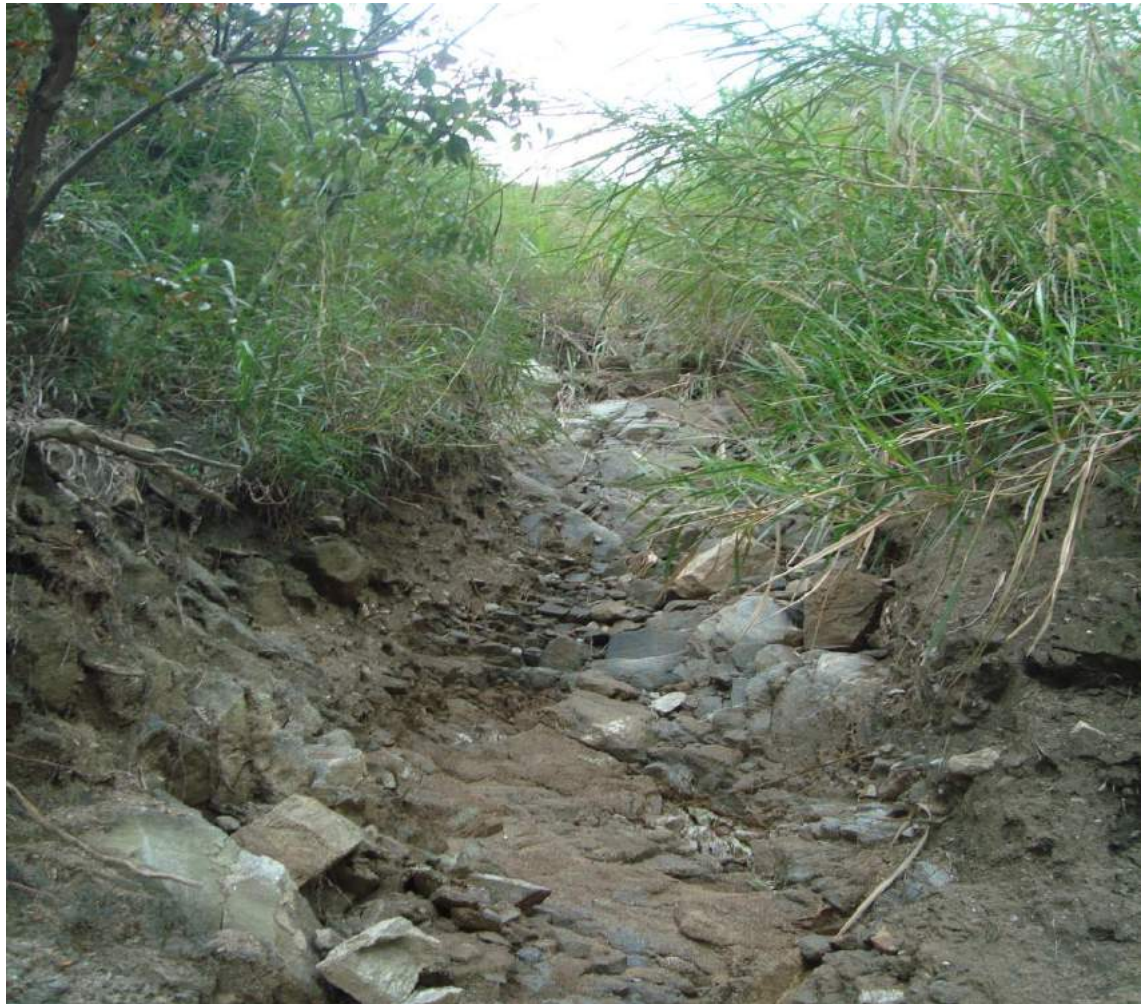
Foto 4: Descripción Fotográfica de la Vía Trasandina Troncal 007 (T-007)
