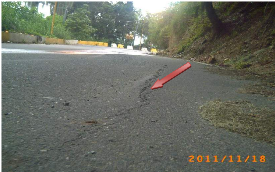
Foto 9: Descripción Fotográfica de la Vía Trasandina Troncal 007 (T-007)
