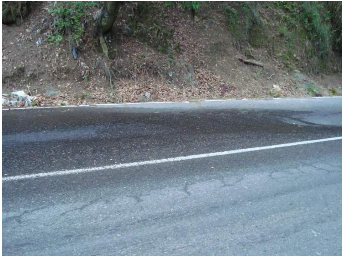
Foto 7: Descripción Fotográfica de la Vía Trasandina Troncal 007 (T-007)
