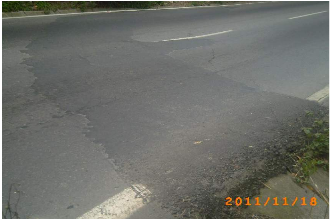
Foto 5: Descripción Fotográfica de la Vía Trasandina Troncal 007 (T-007)
