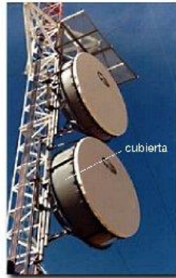
Figura 10. Cubierta utilizada para reducir el nivel de los lóbulos secundarios.
