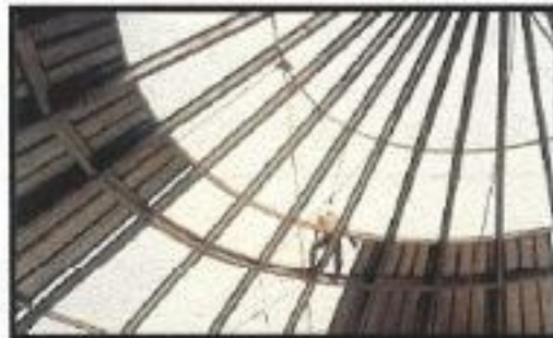
Figura 2.3 Estructura interna de la celda de un silo durante su montaje.
