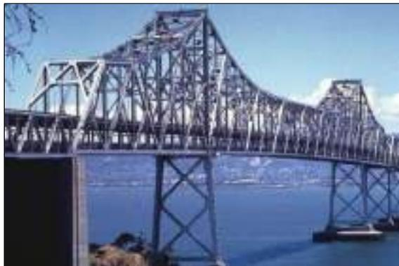
Figura 6. Puente en armadura
