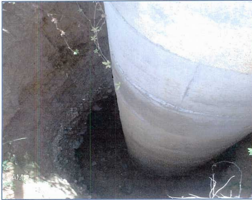
Fotografía 4.2: Pozo artesanal donde se aprecian la disposición de las capas litológicas
