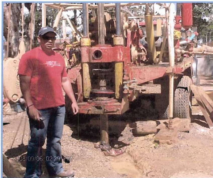
Perforación de Pozo (Urb. Yucatán)
