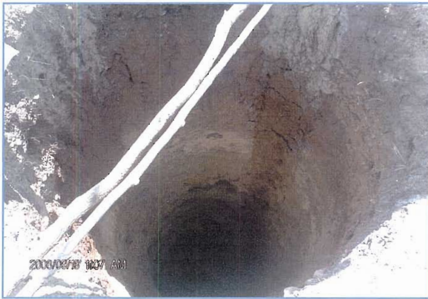
Construcción de Aljibes (cordero)
