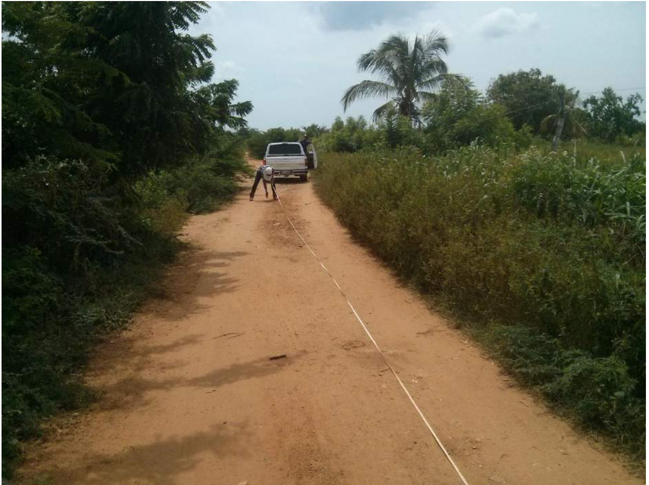
Figura 15. Proceso Medición longitudinal de la ruta del acceso vial para las urbanizaciones Villa Santa Rita y San Ignacio en el municipio Santa Rita, parroquia Santa Rita.
