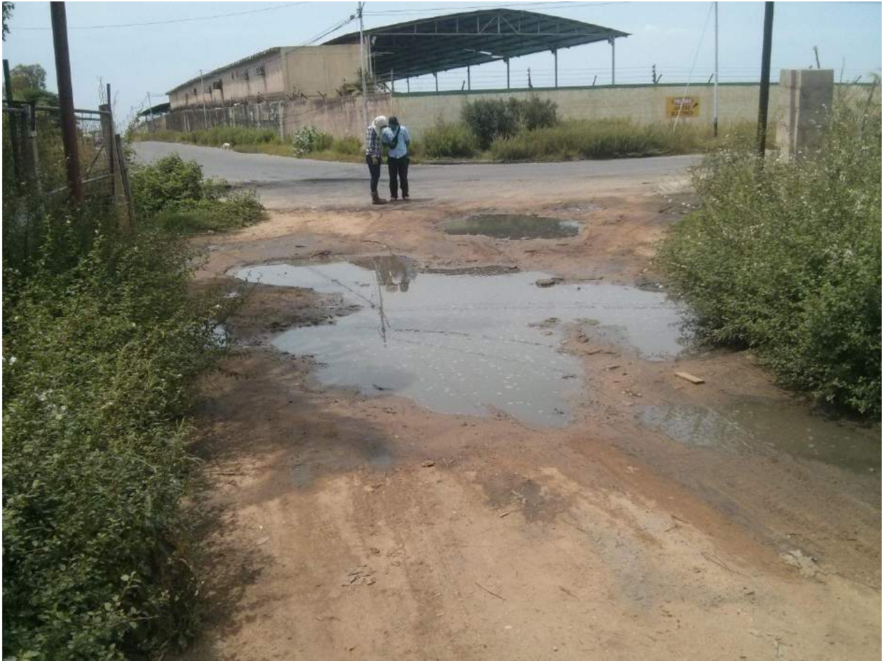
Figura 14. Inicio de la ruta del acceso vial para las urbanizaciones Villa Santa Rita y San Ignacio en el municipio Santa Rita, parroquia Santa Rita punto A.
