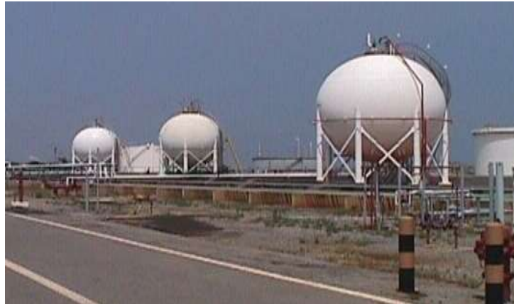
Figura 4.3. Esferas de propano.
