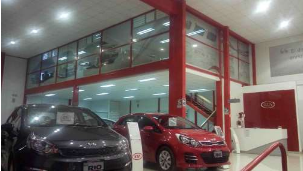
Fotografía 26, Oficinas administrativas sin ventilación (2da planta).
