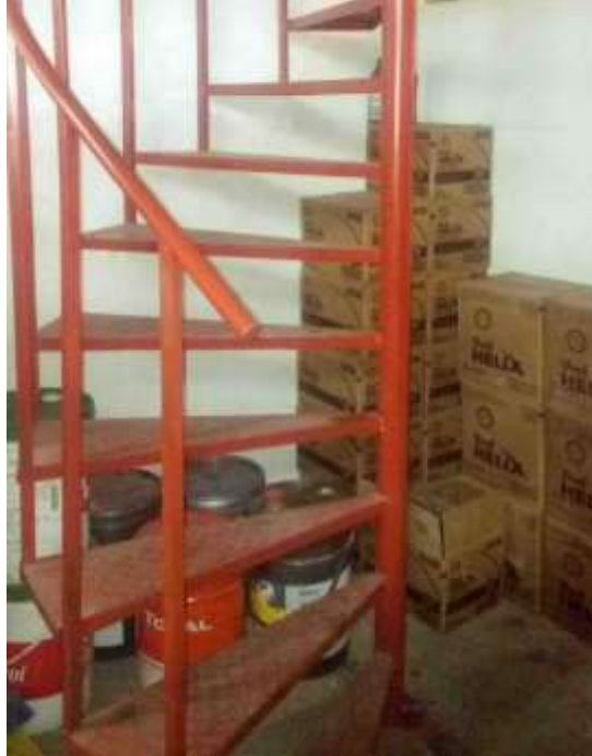
Fotografía 24, Escalera inestable en almacén de repuestos.
