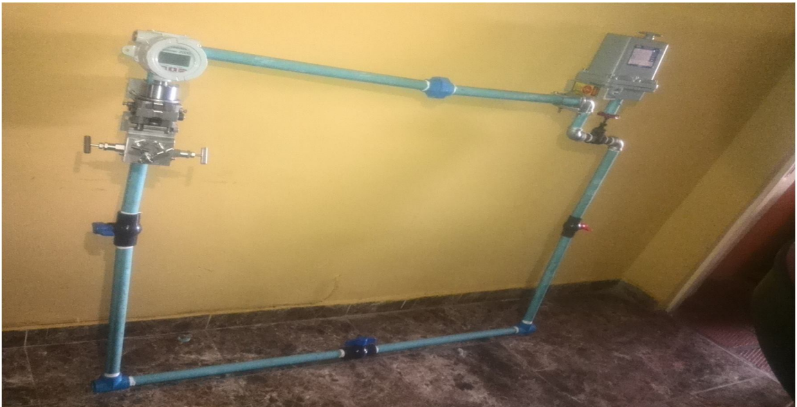
Fig 12. Construcción del prototipo 1 Fuente: Chacin, Estrada, Perez (2017).
