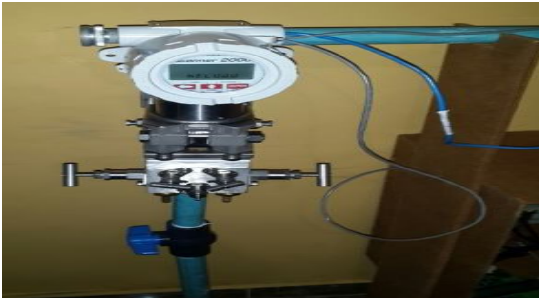
Fig 14. Construcción del prototipo 3. Fuente: Chacin, Estrada, Perez (2017).
