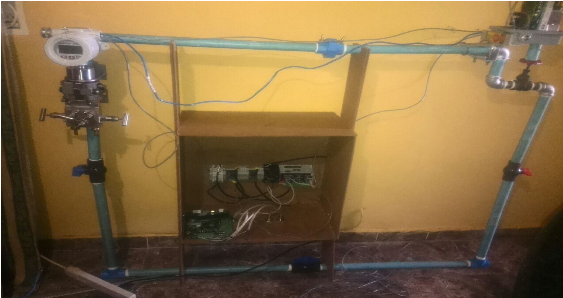
Fig 16. Construcción del prototipo 5. Fuente: Chacin, Estrada, Perez (2017).
