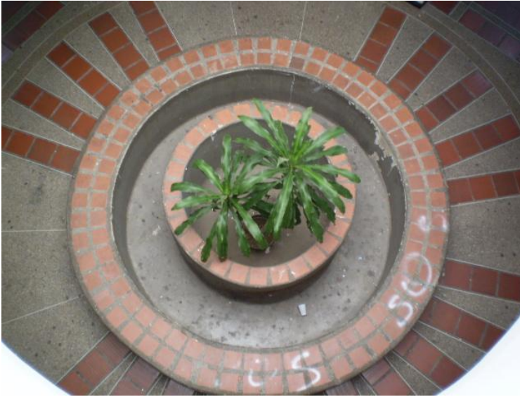
11.- Redoma central en el piso 1 donde se plantea instalar la escalera como acceso.
