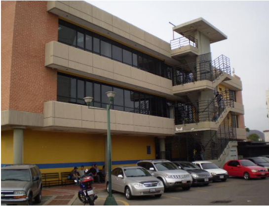
16.- Foto de la edificación donde se aprecian las escaleras principales.
