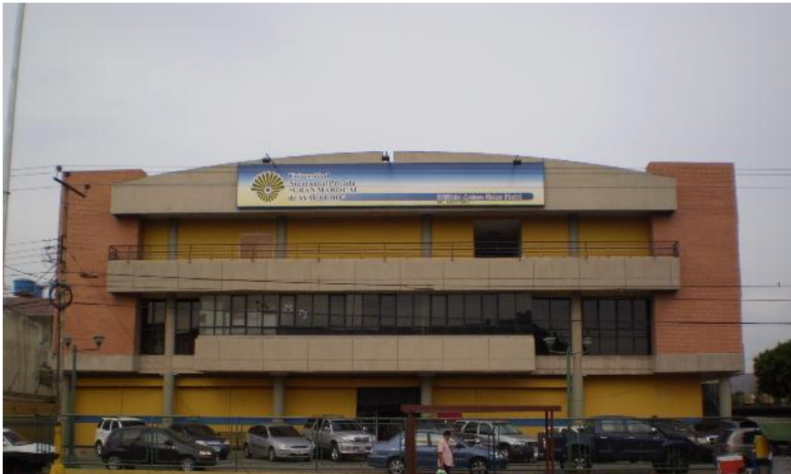
17.- Foto de la vista frontal de la edificación.
