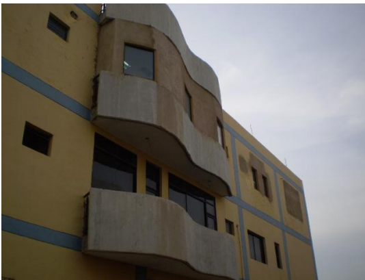
18.- Fachada posterior donde se aprecian los otros tres balcones.
