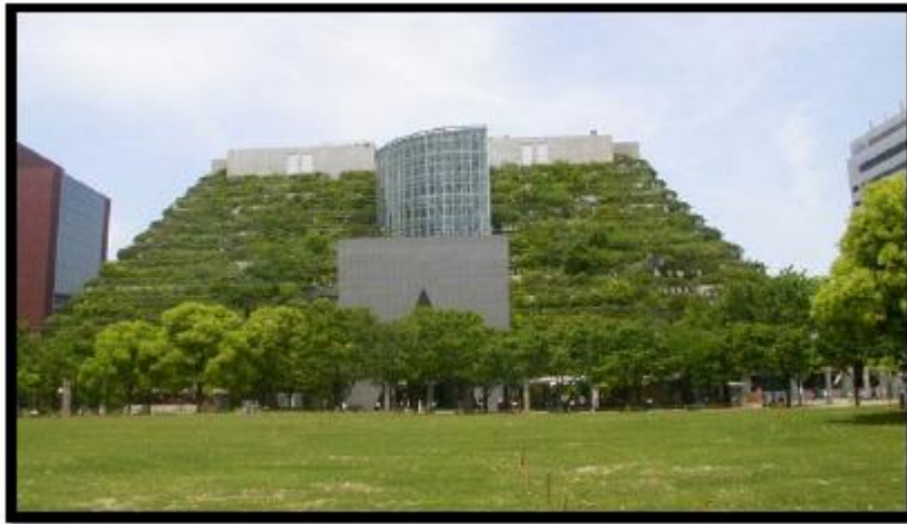
Fig. N°2.15 Ejemplo de plantas de vegetación intensiva. Nota. Tomado del trabajo de grado de Irais Guadalupe Sánchez Mora.
