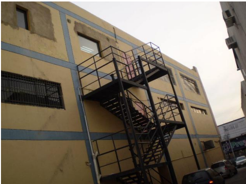
20.- Fachada lateral izquierda donde se aprecia la escalera de emergencia.
