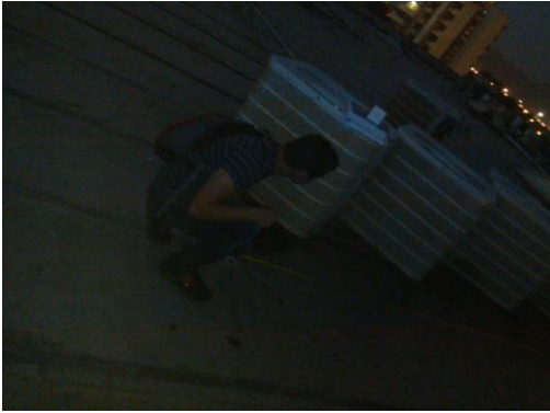
19.- Mediciones y ubicación de los equipos en el techo.
