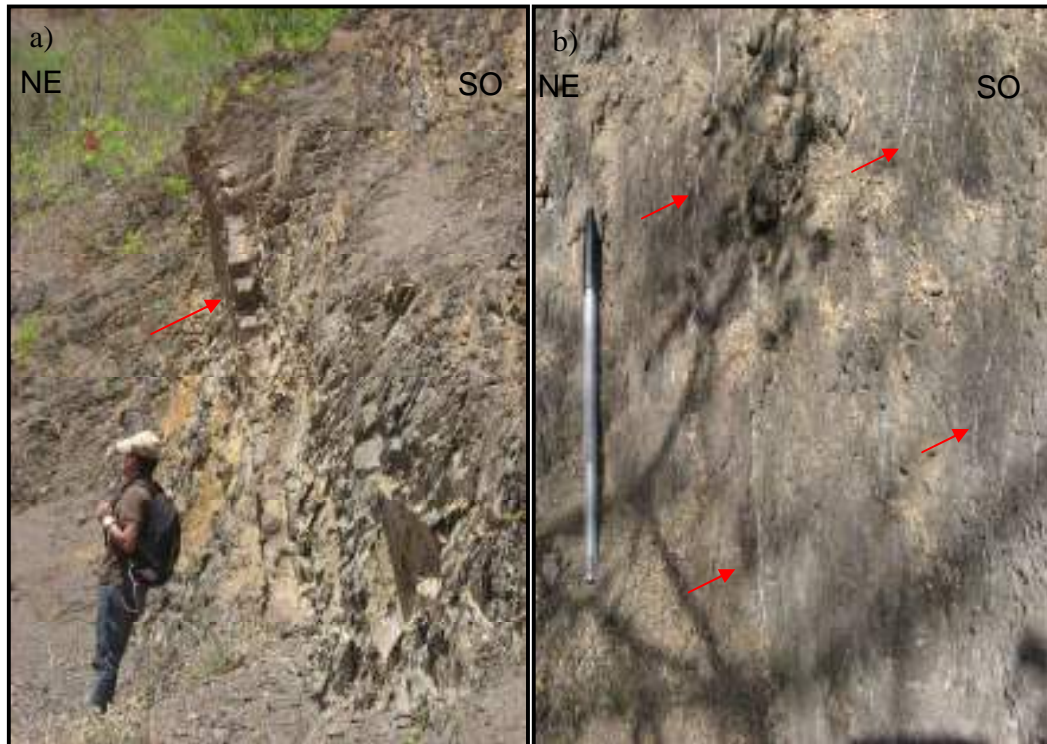
Fig. 4.9. Formación Areo. a) Obsérvese los estratos de areniscas masivas de baja potencia y geometría tabular que se intercalan en las lutitas (flecha roja). b) Detalle las venas de yeso milimétricas intercaladas en las lutitas (flechas rojas)
