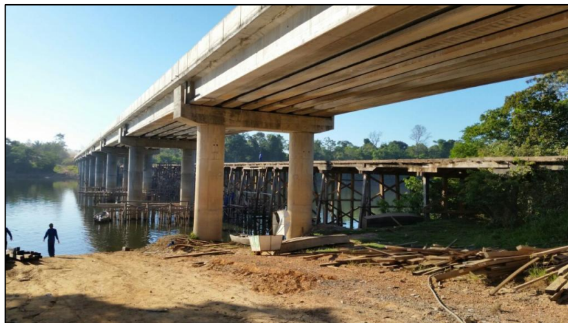
Figura 3.4 - Ponte de concreto no estado de Mato Grosso, sobre o Rio Aripuanã, na rodovia MT-208 (Fonte: www.mt.gov.br )
