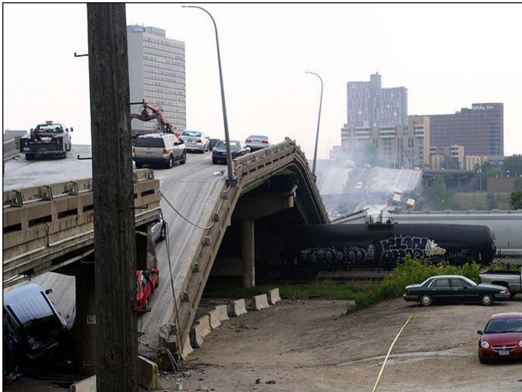
Figura 2.2 - Desabamento de ponte em Minneapolis em 2007 (Fonte: internet)
