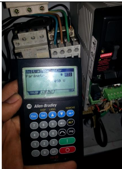
Ilustración 97 Programando parámetro P031. Fuente: El autor.
