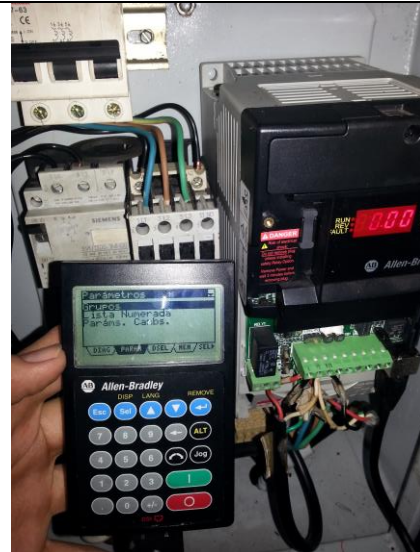
Ilustración 96 Pantalla de ingreso de parámetros. Fuente: El autor.
