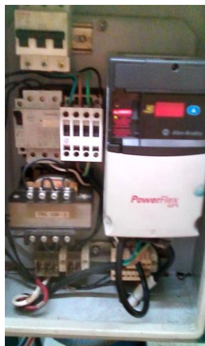
Ilustración 92 Circuito de control.
