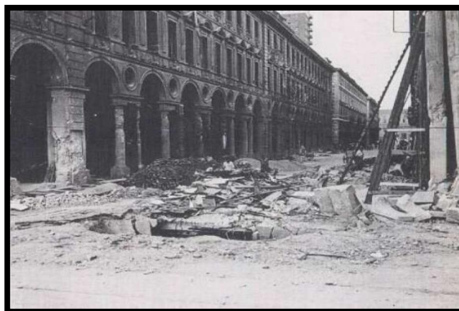
Figura 1.1. Via Roma, Torino. Incursione del 13 Luglio 1943. Archivio dei Vigili del Fuoco di Torino 2 .
