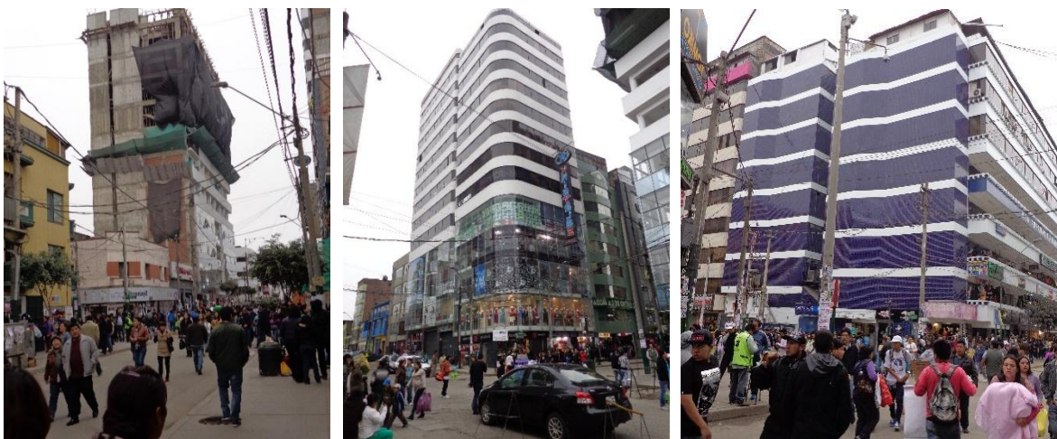
Image 11 : Construction des nouvelles galeries Source : Propre. Avril 2013
