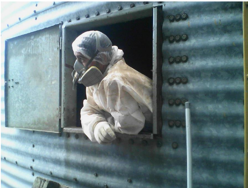
En la imagen se observa que el tamaño de la entrada al silo es pequeña comparada al tamaño del trabajador, tiene una medida de 60cm x 60cm
