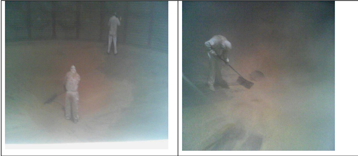
Trabajadores realizando el proceso de limpieza en los silos con poca pendiente de inclinación en las tolvas
