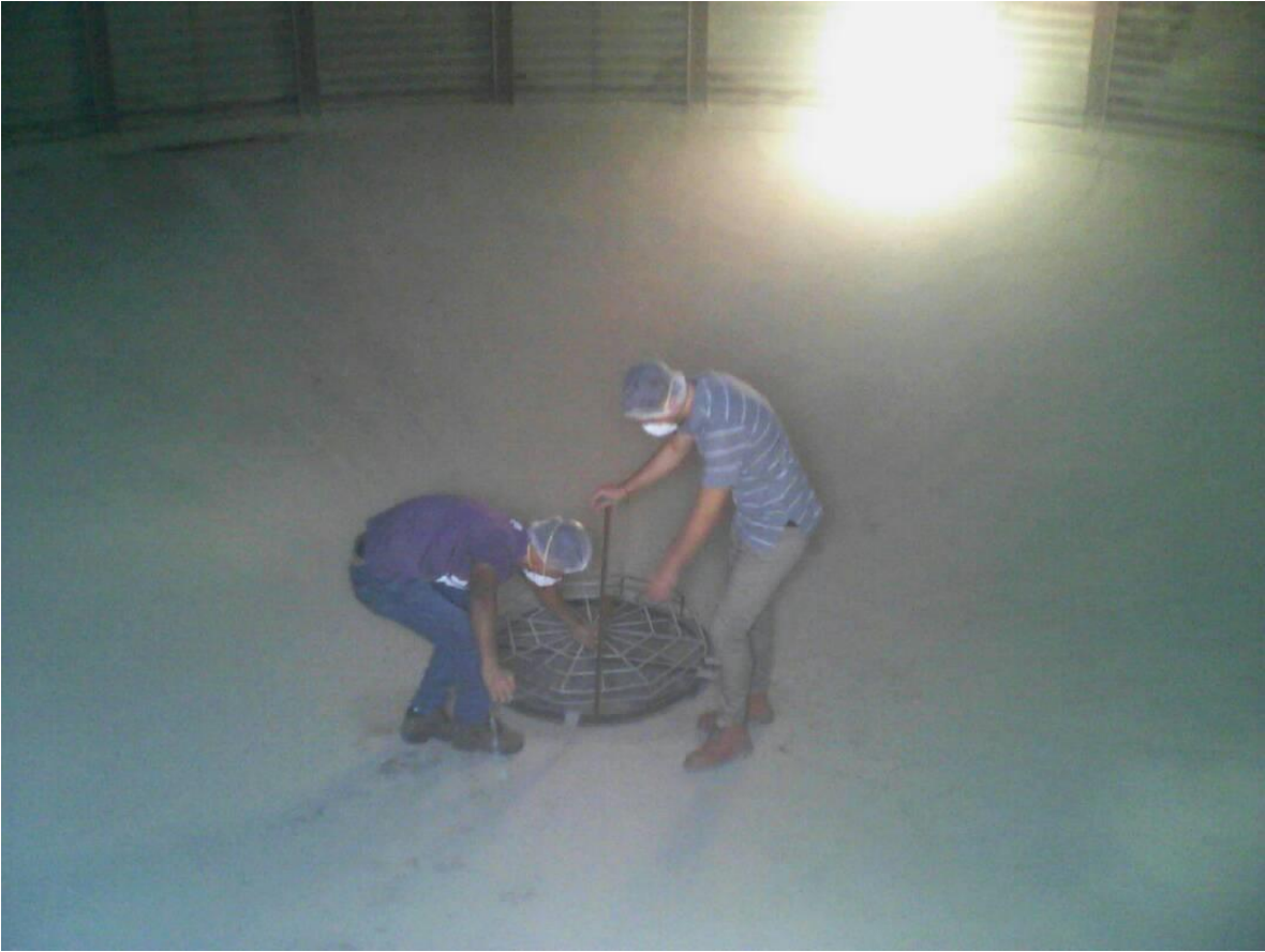
Medición de altura de rejilla de protección ubicada en el fondo del silo
