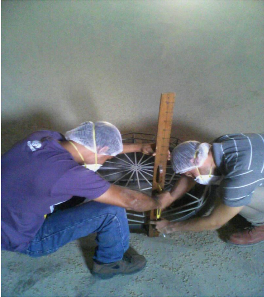
Medición de altura de rejilla de protección ubicada en el fondo del silo
