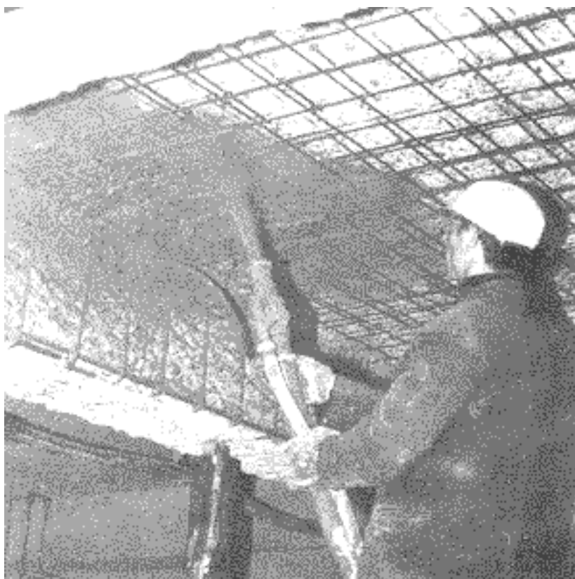
Photo 1.2. Réparation par béton projeté
