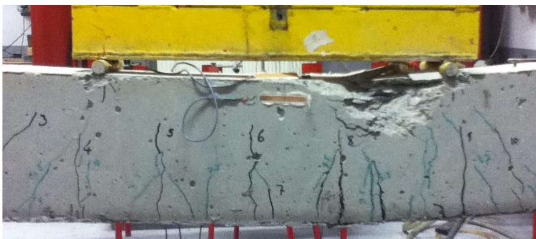
Photo. 2.16. Distribution des fissures de la Poutre renforce par 3 Couches de TRC (P3)
