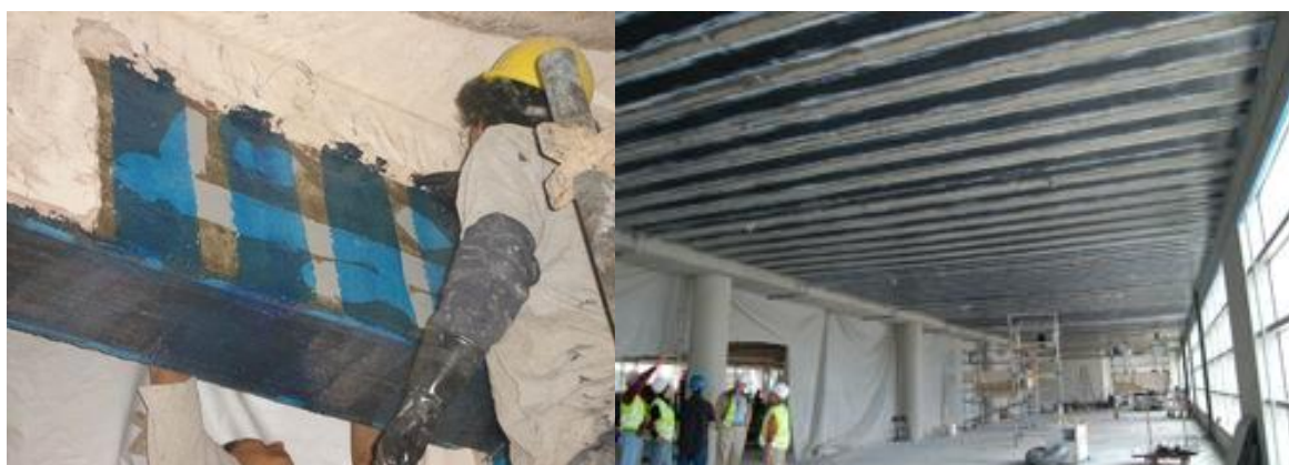
Photos 1.4. Réparation par matériaux composite
