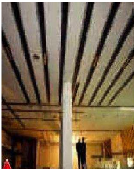
Photo 1.1. Renforcement par tôles collées
