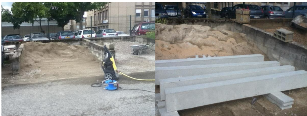
Photo 2.2. Sablage des poutres
