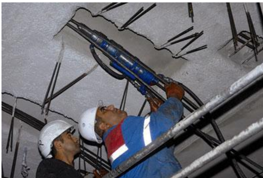
Photo 1.3. Précontrainte additionnelle (Freysinet)
