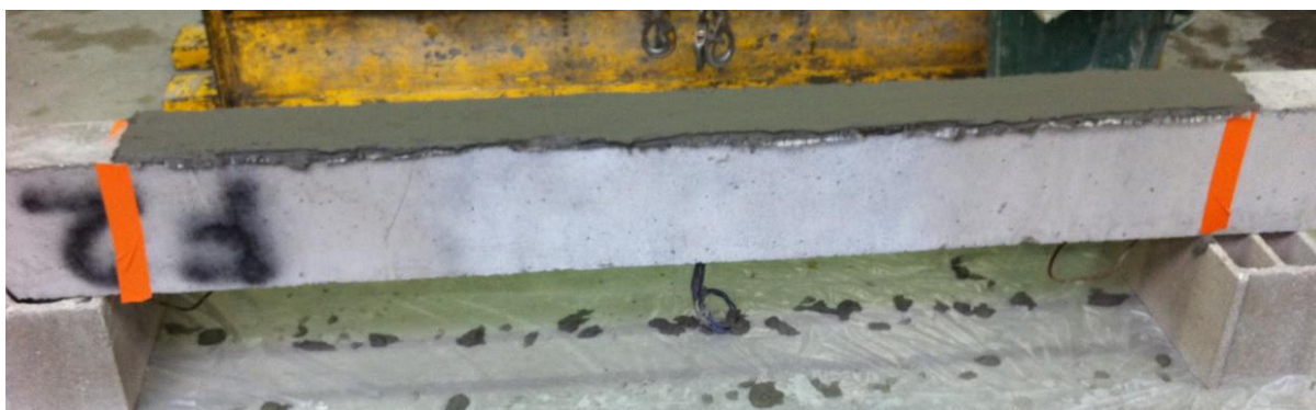
Photo 2.6. Mise en place du renfort composite sur la poutre
