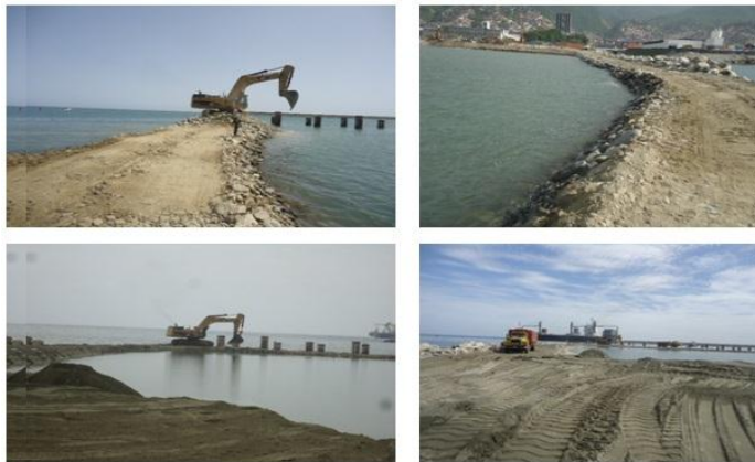
Figura 9. Preparación del sector oeste para la etapa de dragado y relleno. Fuente: Fases de Ejecución. Bolipuertos (2014).
