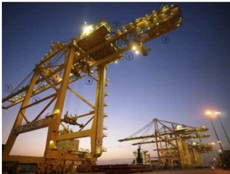
Figura 8. Grúa tipo pórtico Ship to Shore. Fuente: Estudio Técnico y Mantenimiento de una Grúa Porta-Contenedores . Fernández (2009). (p.3).
