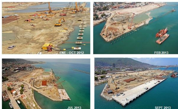
Figura 12. Cronología de la obra. Fuente: Fases de Ejecución. Bolipuertos (2014).
