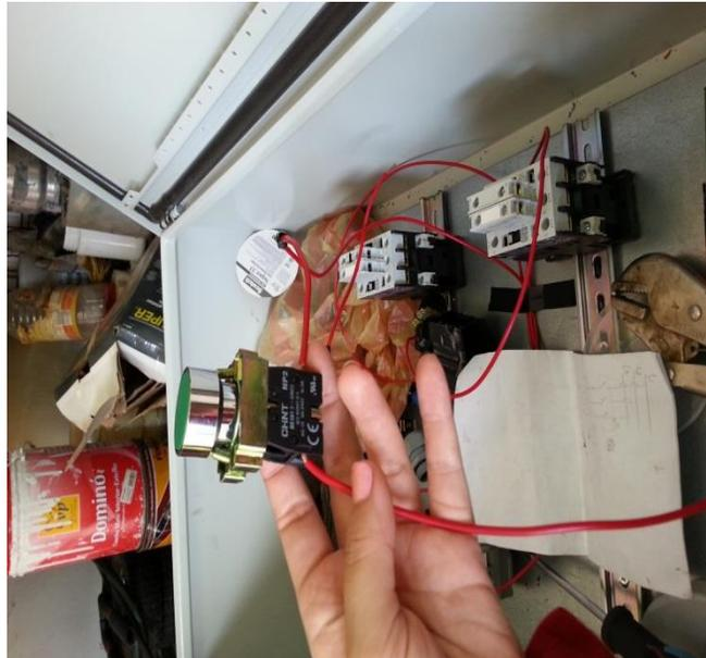
*Imagen 41. Conexión de pulsadores a circuito. Fuente: Propia (2013).*
