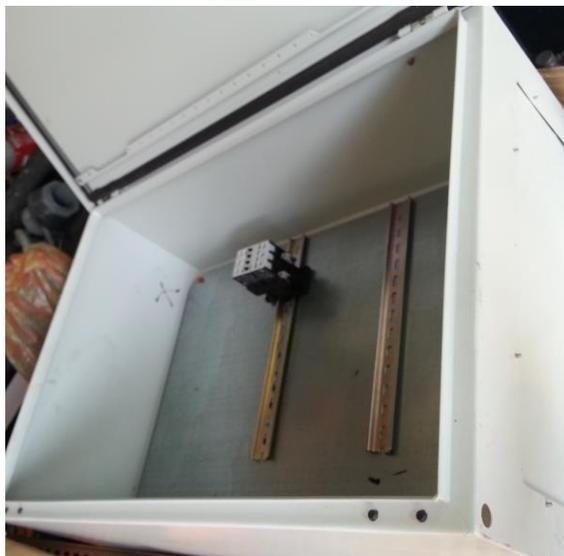
*Imagen 39. Instalación de riel DIN 25 en cajetín y contactor. Fuente: Propia (2013).*
