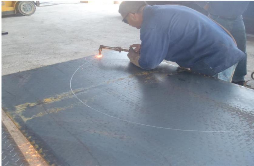
*Imagen 5. Cortando la lámina mediante el equipo oxicorte. Fuente: Propia, (2013).*
