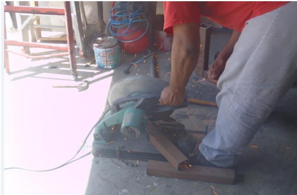
*Imagen 1. Cortes de tubo estructural 60x60 a un ángulo de 45. Fuente: Propia, (2013).*
