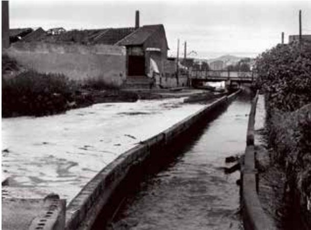
Colector del Bogatell a cielo abierto. Al fondo, el puente metálico del ferrocarril. 1985.
