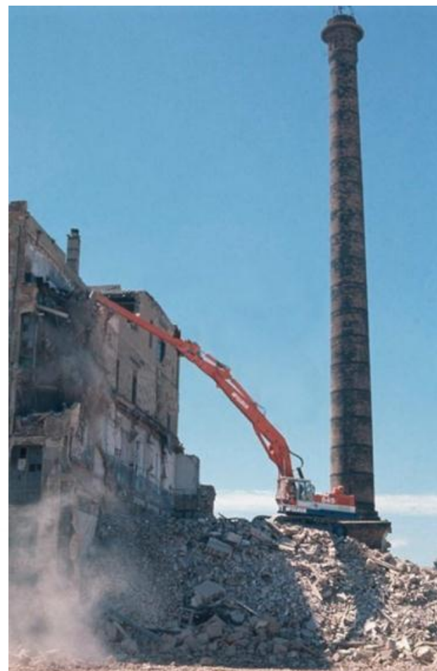
Enderrocament de can Folch, 1987, fotografia: Llorenç Martí
