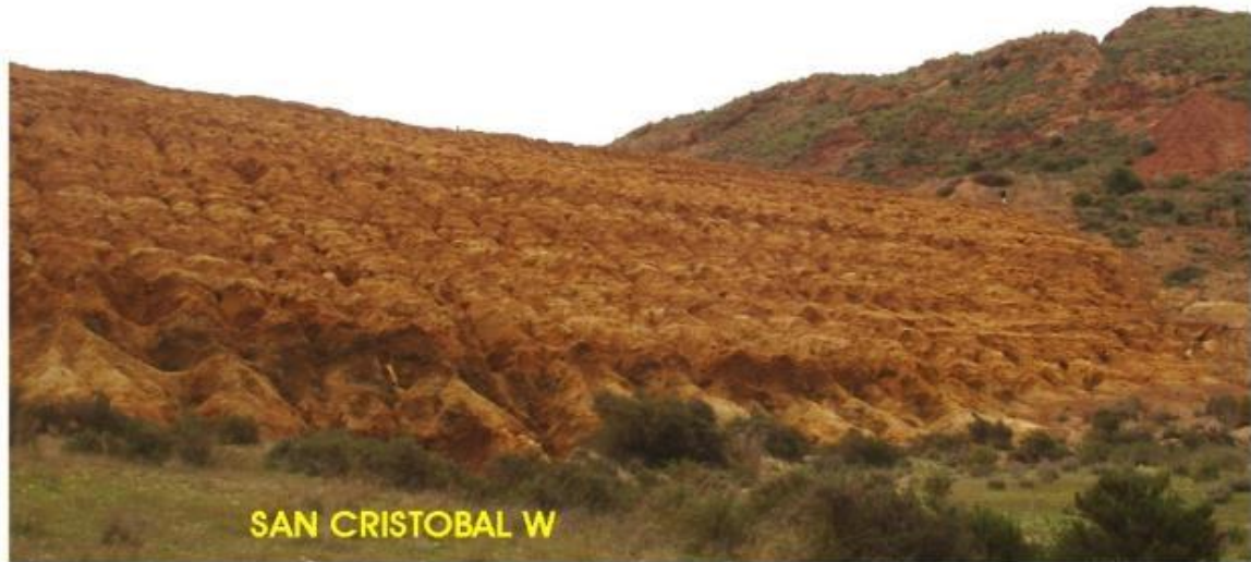
Figura A8. Vista del dique de la presa de Relaves San Cristóbal Oeste.
