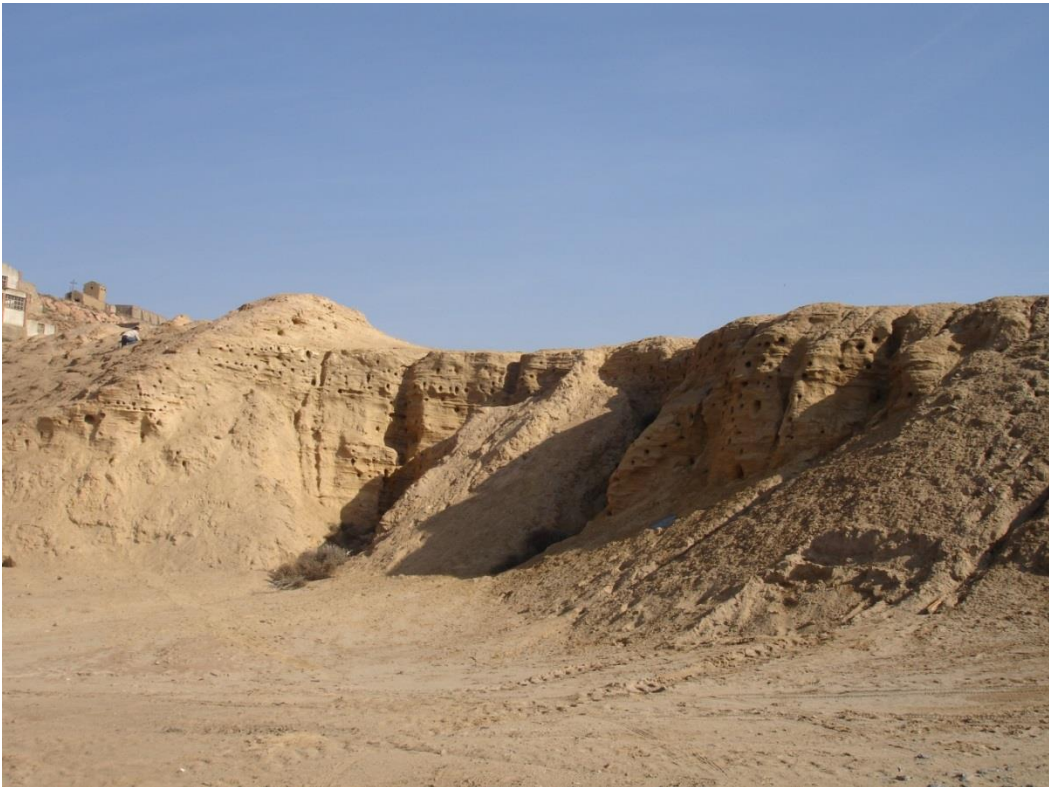
Figura A5. Deslizamiento del dique de la presa La Económica.
