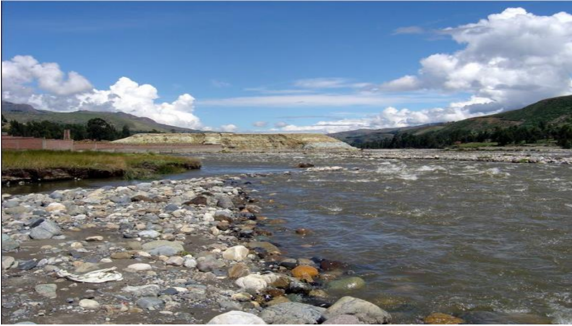
Figura 4.4 Vista de la presa de relaves de Ticapampa junto al Río Santa.
