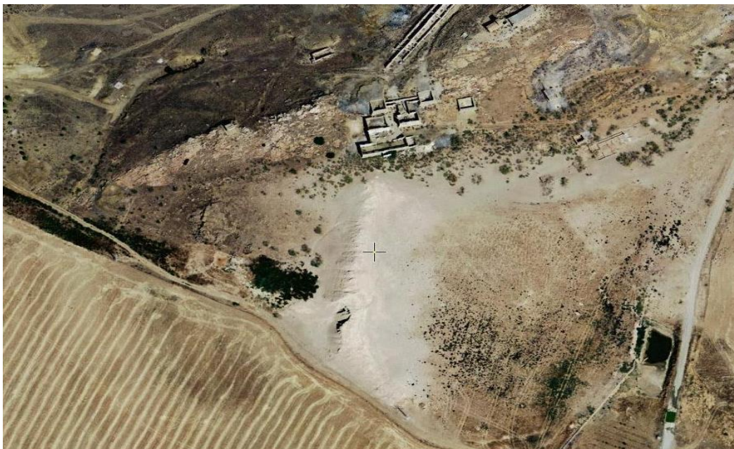
Figura A2. Vista satelital de la presa La Económica.
