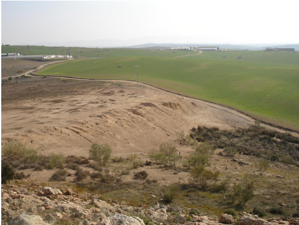
Figura A4. Panorámica general de la presa La Económica.
