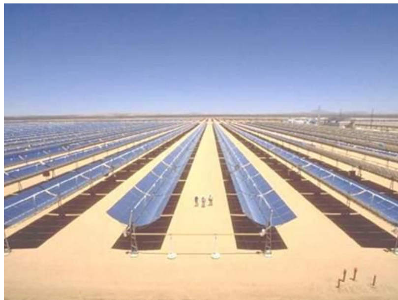
Planta de Energía Solar, Rovigo - Italia
