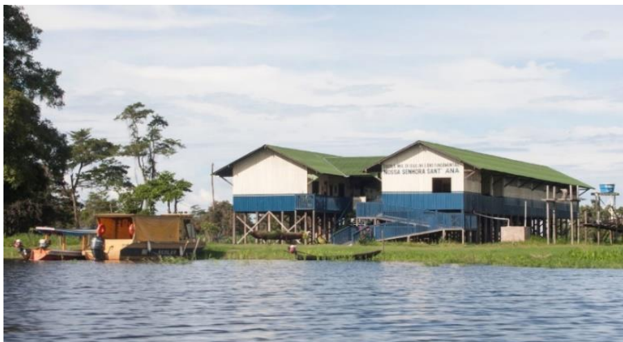
Figura 1: Exemplo de estrutura de madeira característica da várzea construída acima do nível do piso por ser uma área anualmente inundada. Na foto a escola da comunidade quilombola de Arapemã. Fonte: Acervo pessoal.
