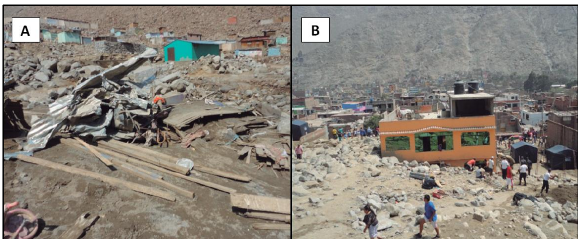
Figure A1.2. Laves torrentielles en 2012 sur la rive gauche de la rivière Rimac, (A) Dans le torrent La Ronda : des logements précaires détruits (B) Dans le torrent Mariscal Castilla : un logement enseveli du quartier Pablo Patrón, seul le troisième étage apparaît dans la figure
