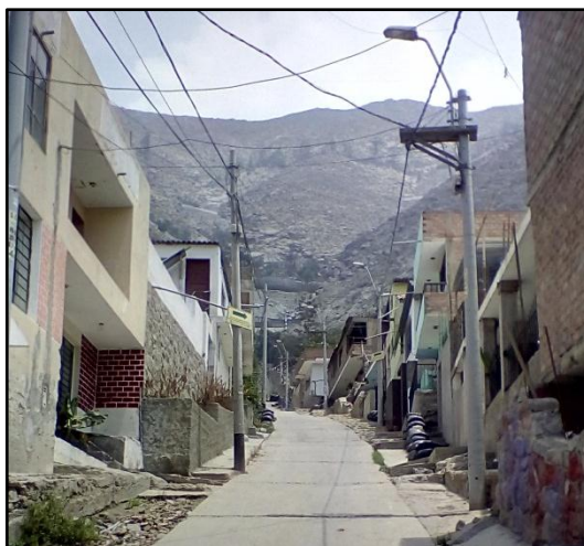
Figure 42. Chenal du torrent Carossio transformé en une piste asphaltée, presque au niveau des logements
