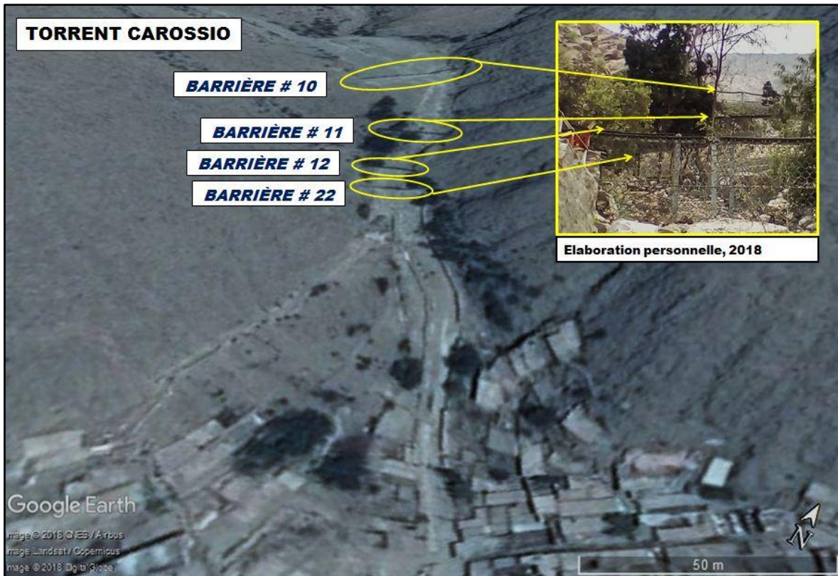
Figure 35. Localisation des barrières dans le torrent Carossio à Chosica, Les barrières sont très proches les unes des autres (entre 5 et 10 m) et très proches de la zone peuplée (qui commence à 50 m de la barrière la plus en aval)
