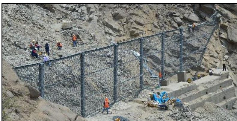
Figure 33. Barrière flexible # 10 dans le torrent Carossio à Chosica (barrière type UX avec 6 supports intermédiaires)
