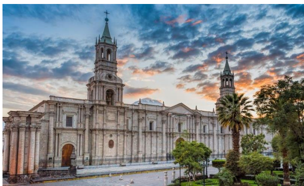
Fig. 114. Cattedrale di Arequipa, localizzata nel Centro Storico della città.
