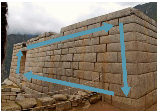
Fig. 65. Uso della forma trapezoidale nelle mura di una casa a Machu Picchu.
