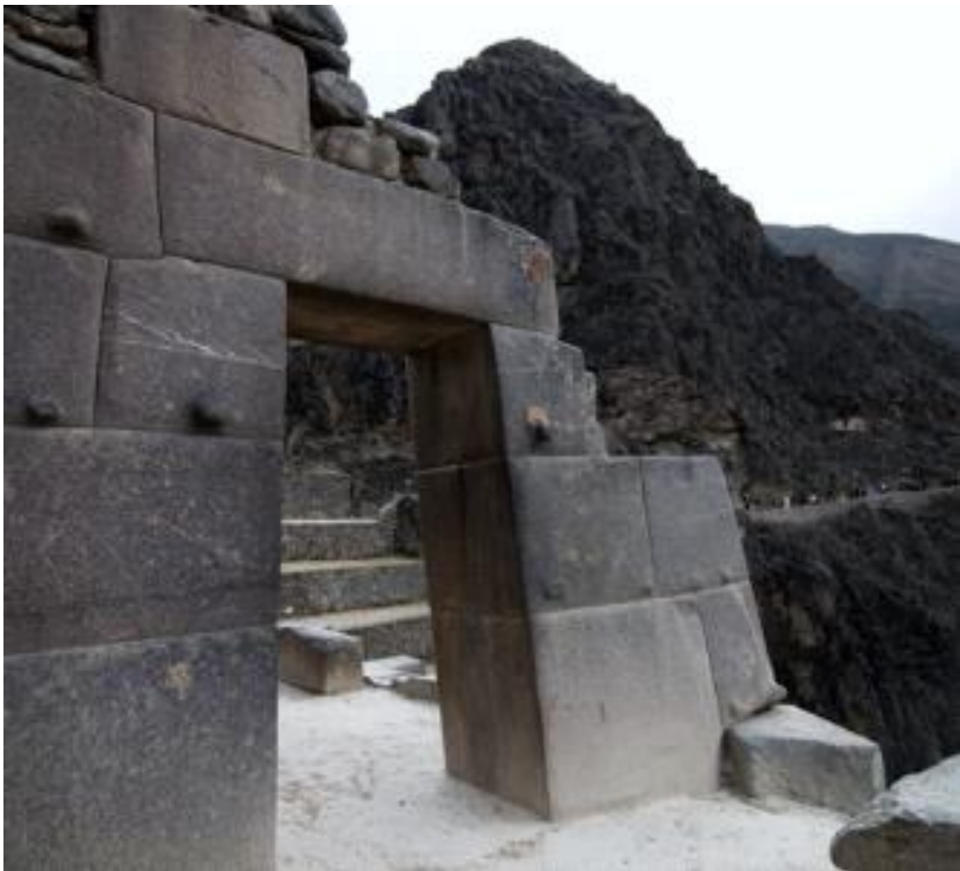
Fig. 81. Tipica porta trapezoidale utilizzata nell'architettura Inca, localizzata nella cittadina di «Ollantaytambo».
