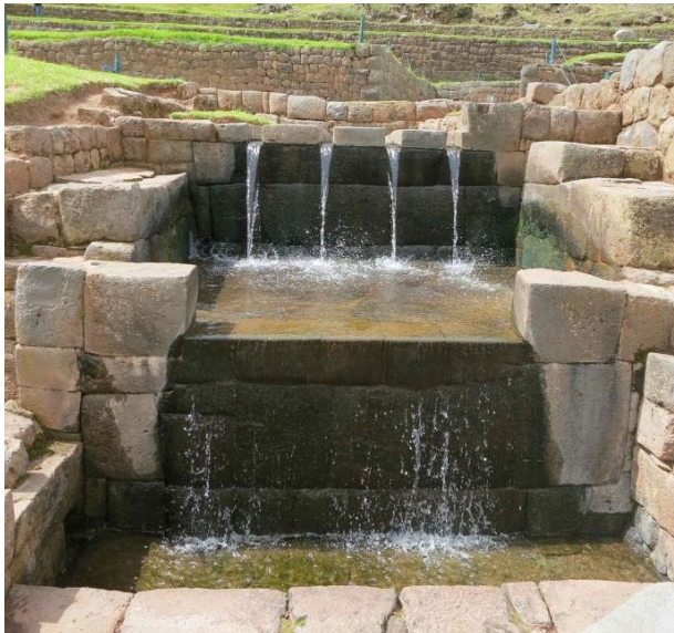
Fig. 49. Fontana a 4 versanti, parte del sistema di irrigazione delle terrazze di Tipón.
