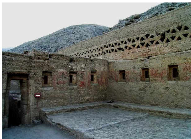
Fig. 69. Uso della terra cruda negli edifici Incas, a Tambo Colorado – Pisco.
