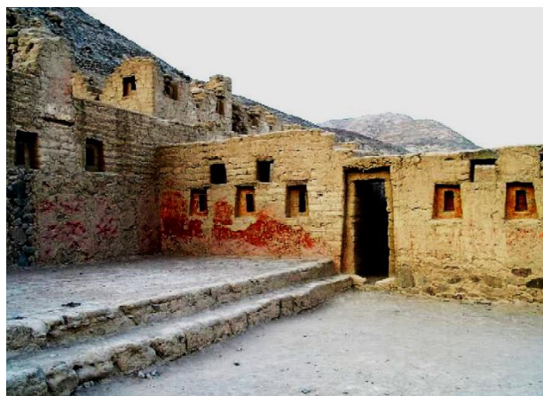
Fig. 70. Costruzioni in terra cruda con aperture trapezoidali a Tambo Colorado.
