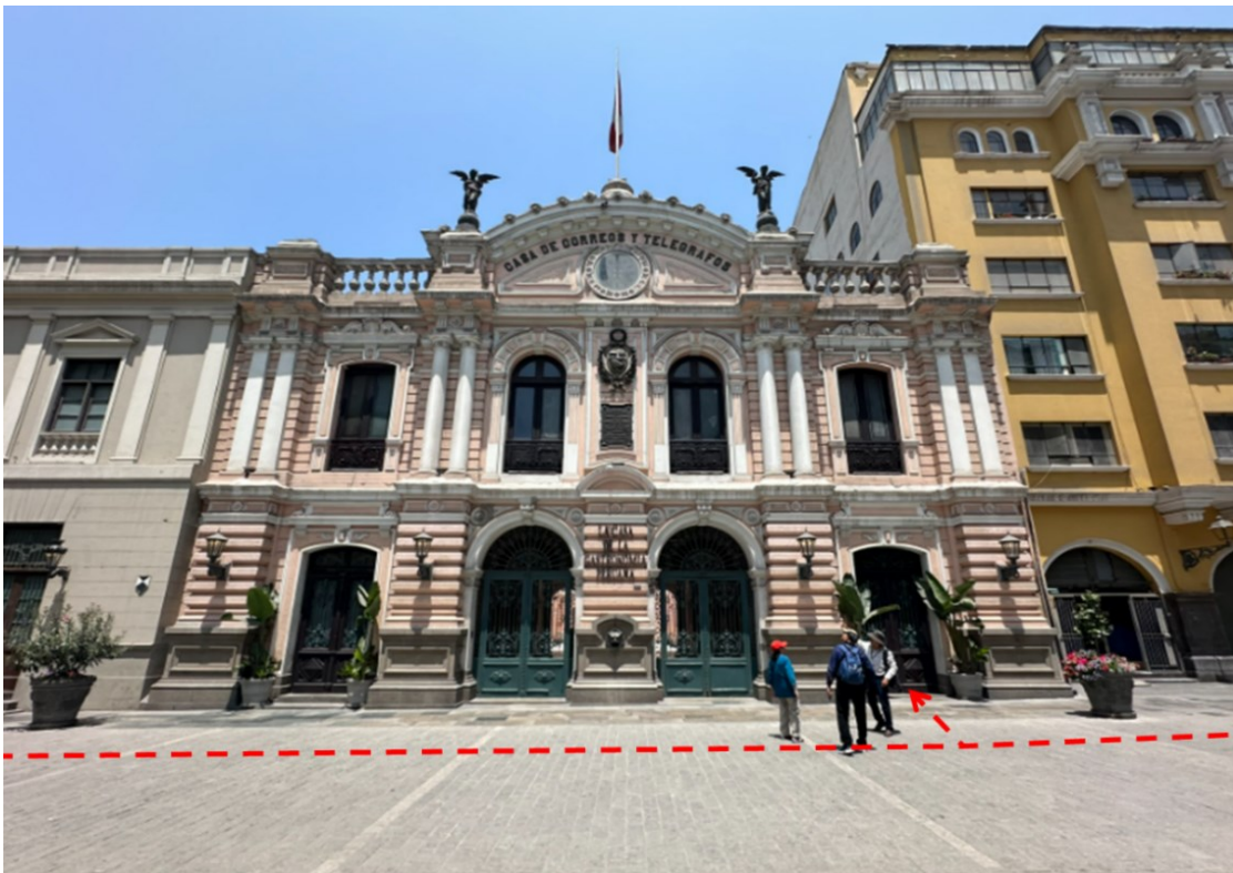
Imagen 71. Fachada principal del inmueble. Fuente: Fotografía propia.
