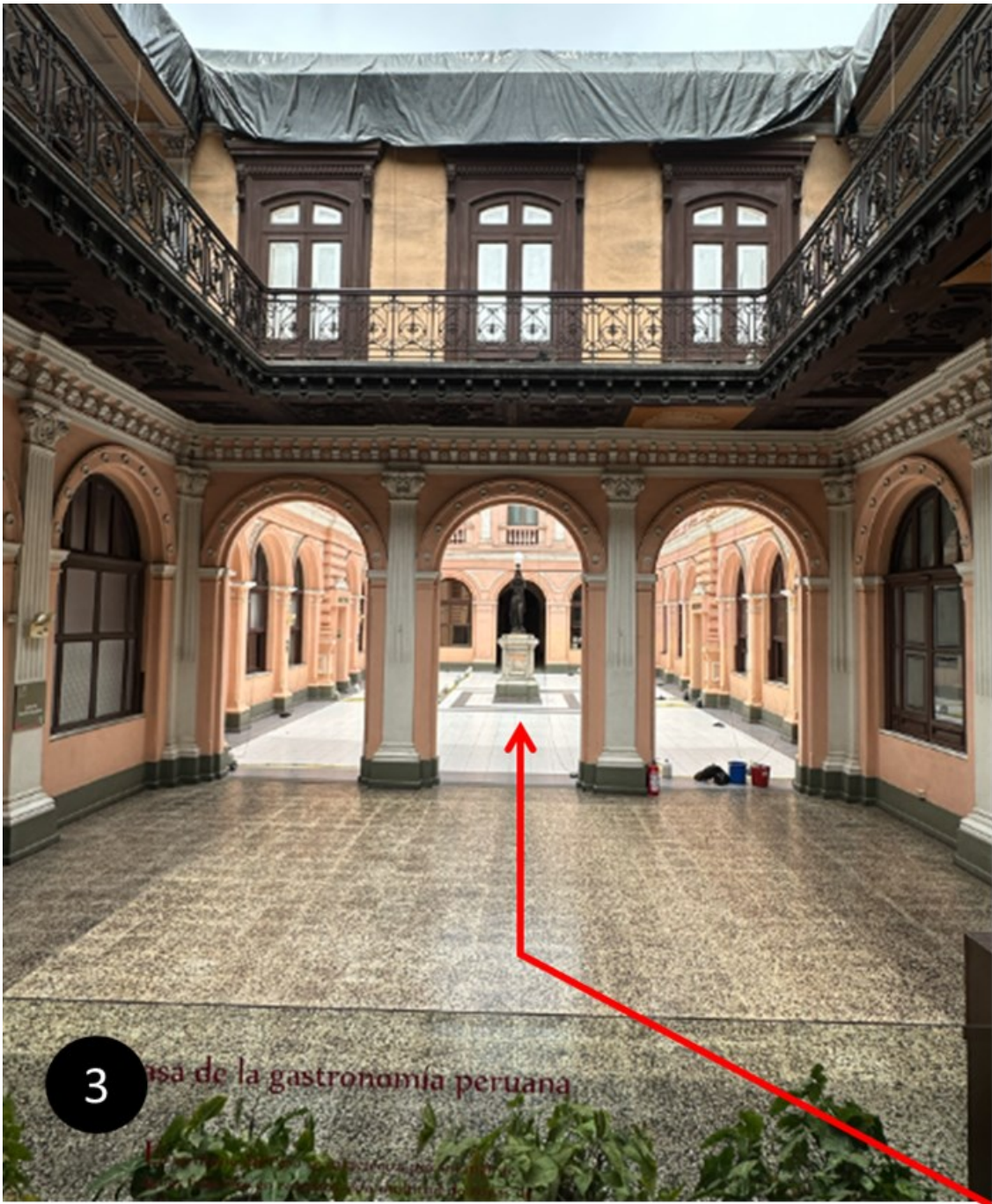
Imagen 77. Fotografía del zaguán. Fuente: Fotografía propia.
