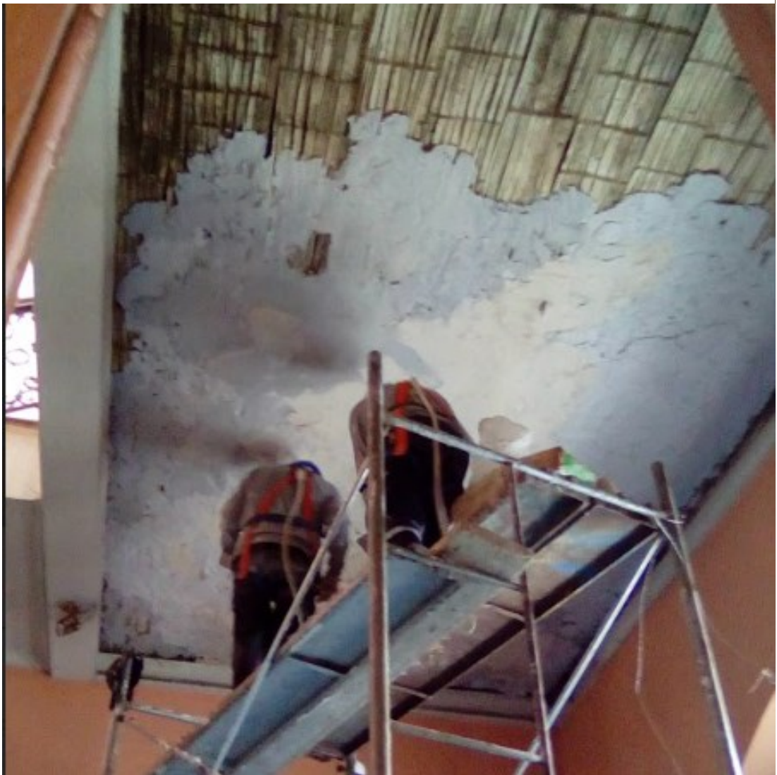
Imagen 62. Restitución de la caña chancada. Arquitecto Sosa Valle, M. (2018, 20 de febrero). Proyecto de Emergencia en la Casa de Correos y Telégrafos - Área de Intervención.
