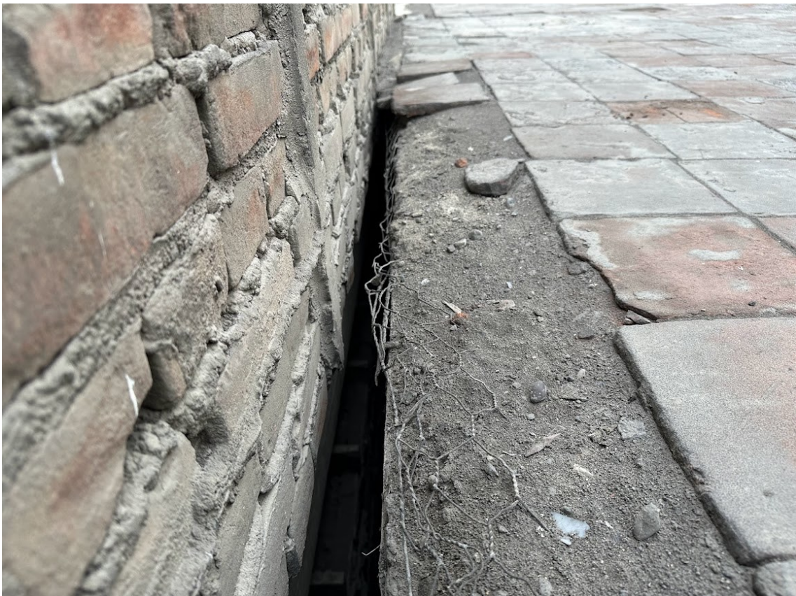
Imagen 124. Pérdida de recubrimiento y de torta de barro en encuentro de la edificación antigua con la ampliación de 1920. Fuente: Fotografía del autor.
