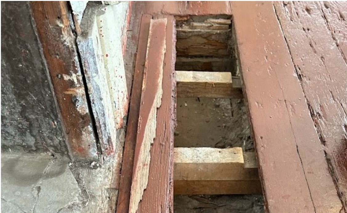
Imagen 24. Detalle del entrepiso de la Fase 1 de la Casa de Correos y Telégrafos de Lima. Fuente: Fotografía propia.
