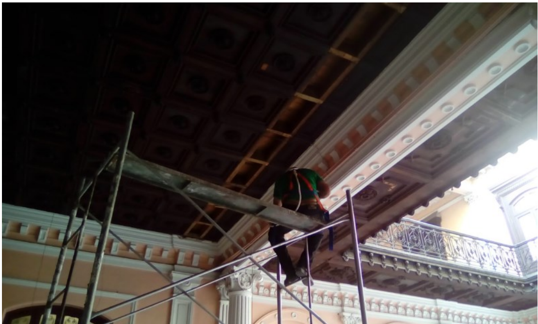
Imagen 64.Retiro de casetones. Arquitecto Sosa Valle, M. (2018, 20 de febrero). Proyecto de Emergencia en la Casa de Correos y Telégrafos - Área de Intervención.
