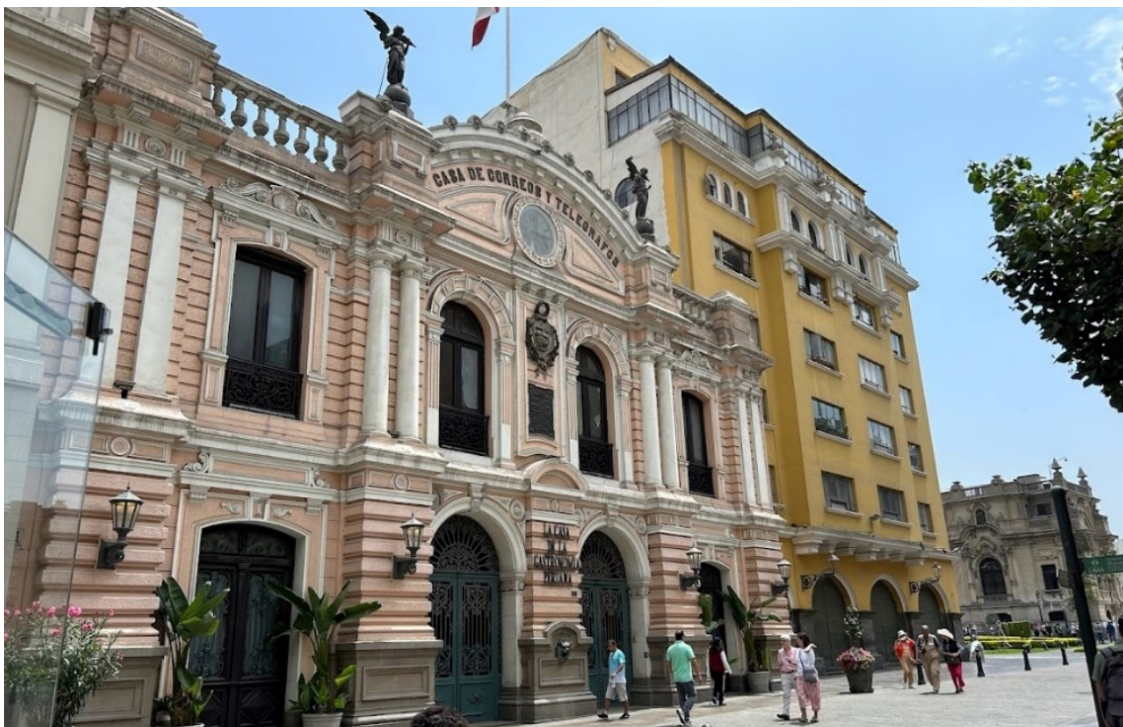
Imagen 7. Fotografía actual de la Casa de correos y telégrafos desde Jr. Conde de Superunda. Fotografía del autor.
