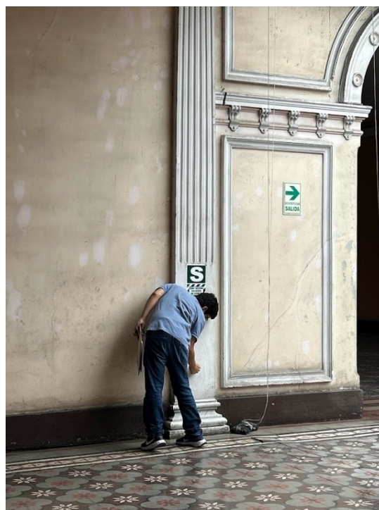
Imagen 2. Inspección estructural. Fotografía del Autor.
