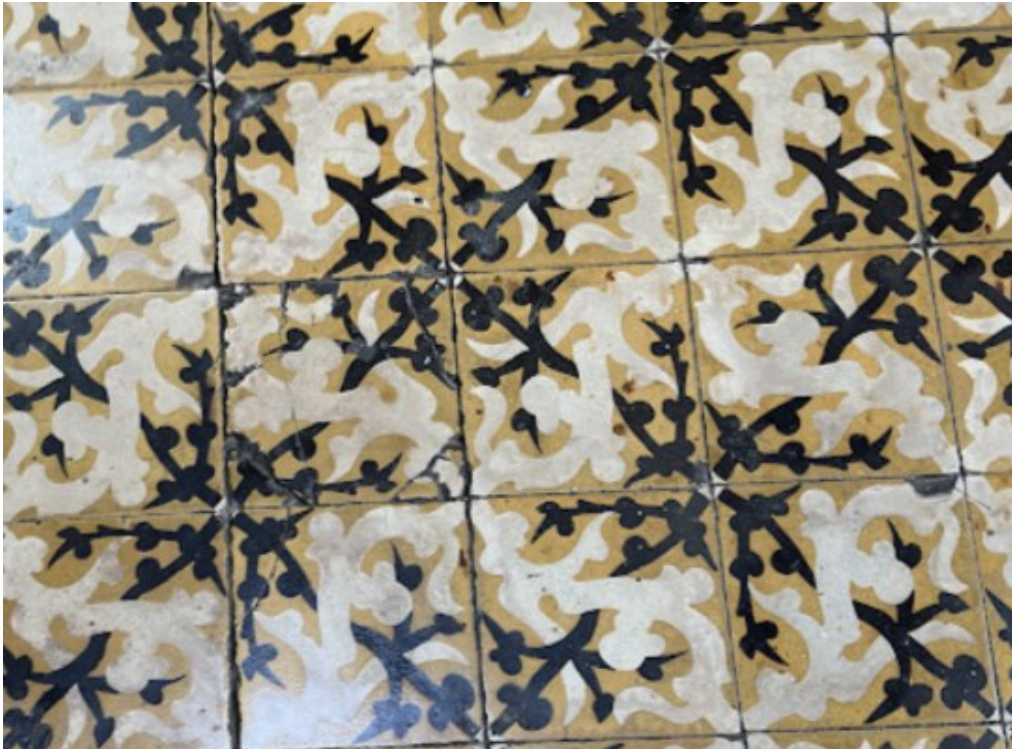
Imagen 82. Baldosas pertenecientes al primer nivel del espacio de la escalera. Fuente: Fotografía del autor.
