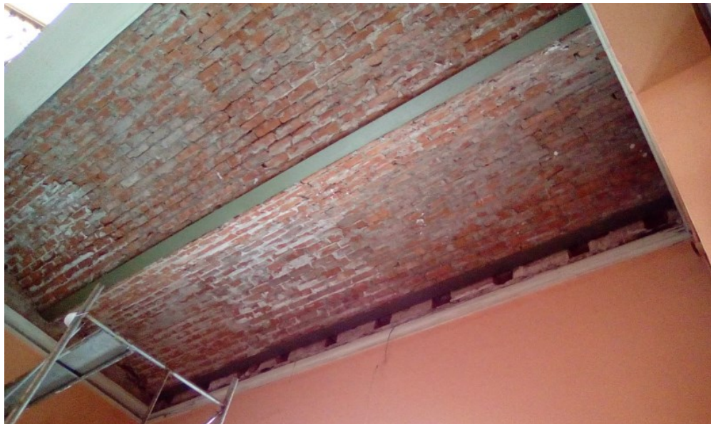
Imagen 60. Retiro del recubrimiento en mal estado del entrepiso. Arquitecto Sosa Valle, M. (2018, 20 de febrero). Proyecto de Emergencia en la Casa de Correos y Telégrafos - Área de Intervención.
