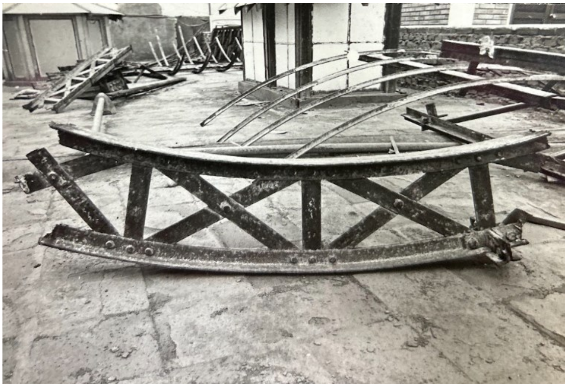
Imagen 58. Imagen del desmontaje de la claraboya, se observan las cerchas. Fuente: Ministerio de Cultura. (1974). Expediente de Retiro de Lucernarios del Edificio del Correo Central de Lima.
